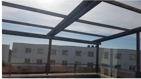
Figura 44 – Pergolato in legno con pilastri 20cmx20cm
