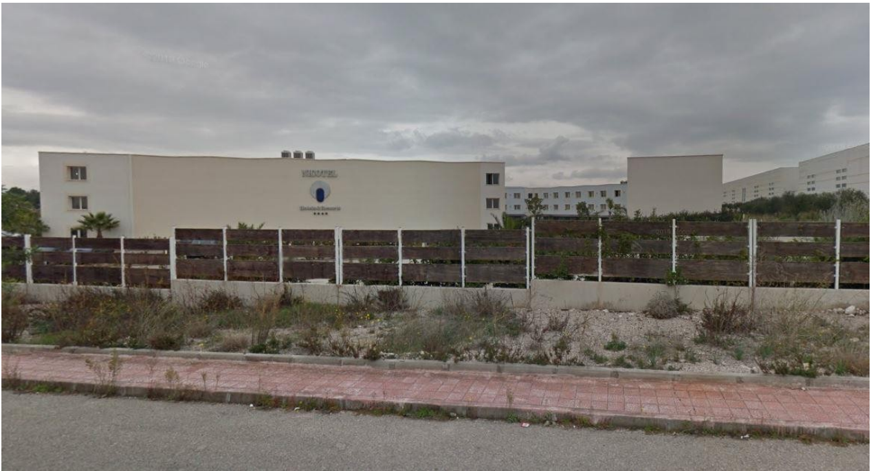
Figura 4 – Vista del complesso edilizio da Sud
