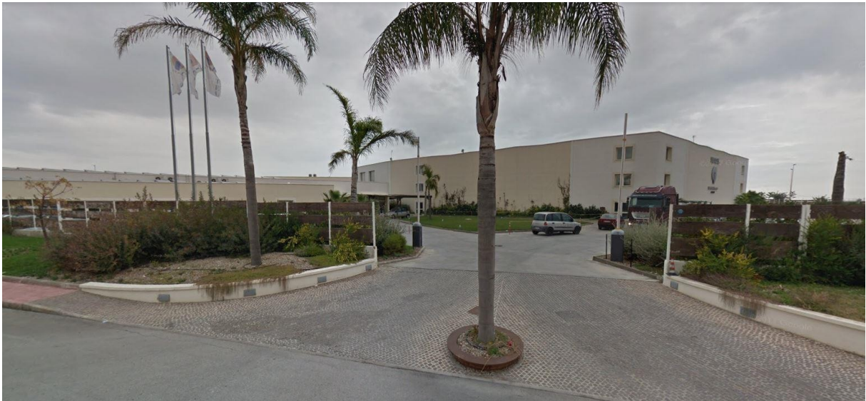
Figura 1 – Vista del complesso edilizio da Ovest
