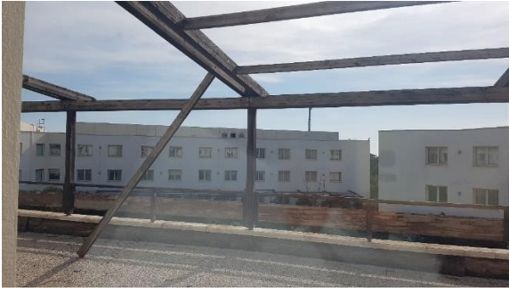
Figura 44 – Pergolato in legno con pilastri 20cmx20cm
