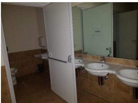
Figura 16 – Bagno tipo dell'albergo
