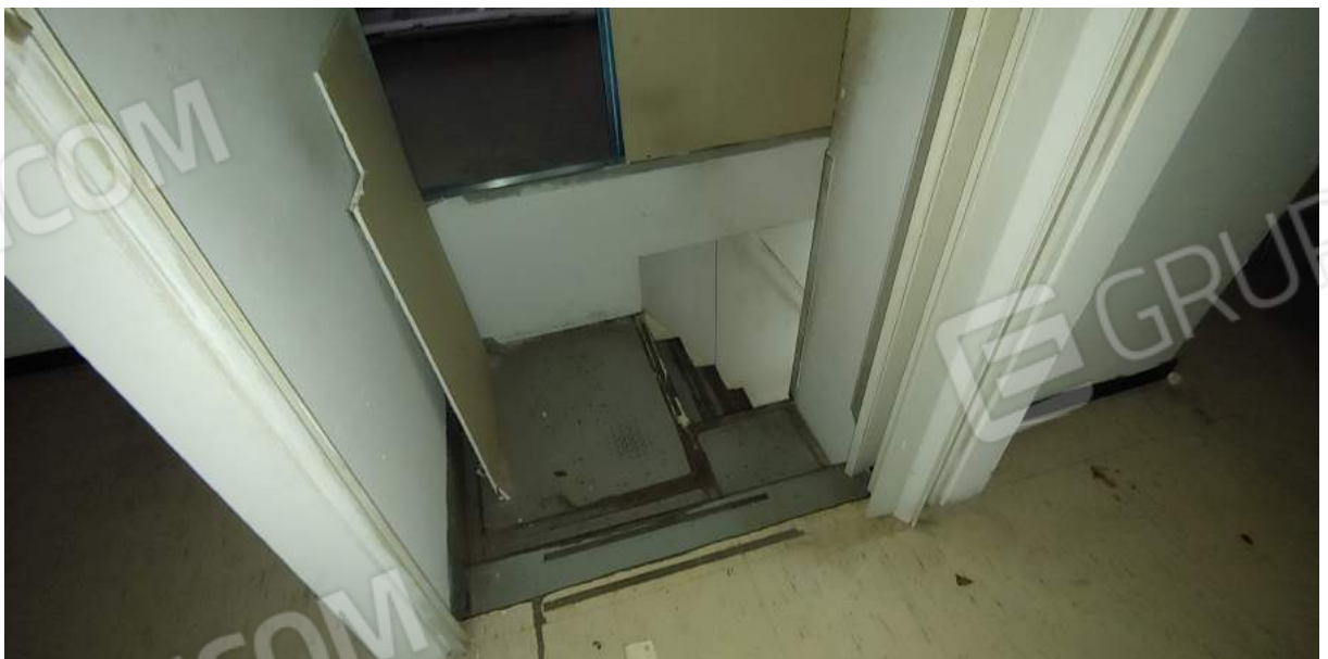
Foto C16 - LOCALE COMMERCIALE - INTERNI - SOPPALCO N. 1
