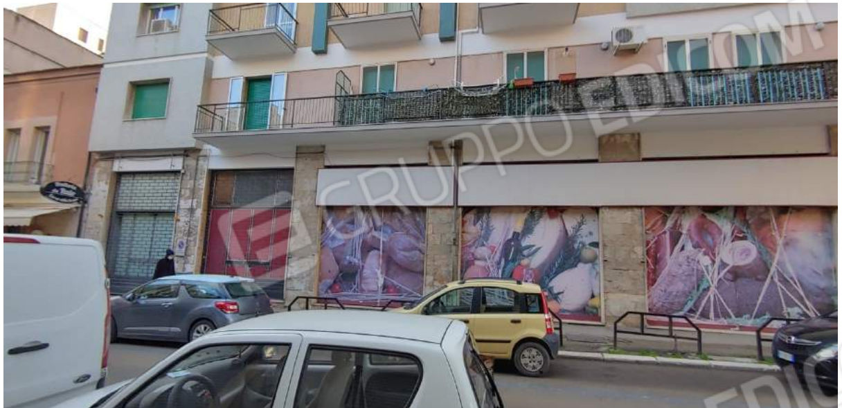
FOTO C6 - LOCALE COMMERCIALE - VIA FIUME N. 4 /A-F - FOGGIA
