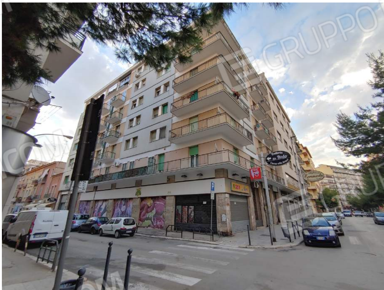
FOTO C2 - PALAZZO ZANASI - VIA CONTE APPIANO N. 20 - FOGGIA
