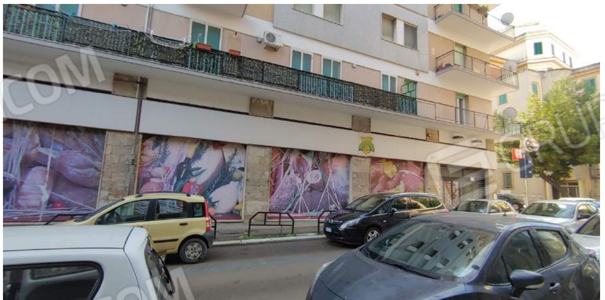
Foto C5 - LOCALE COMMERCIALE - VIA FIUME N. 4 /A-F- FOGGIA
