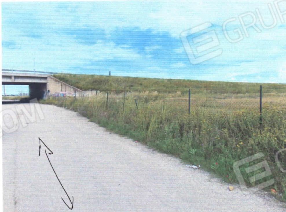
FOTO N.6: Stradina interpodereale (F.129, p.la 289) ; recinzione metallica sulla dx.
