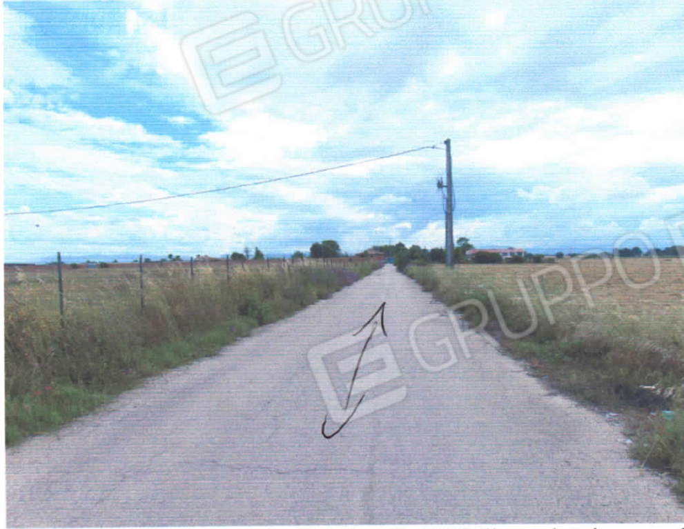
FOTO N.7: Stradina interpodereale (F.129, p.lla 289); linea elettrica su pali.
