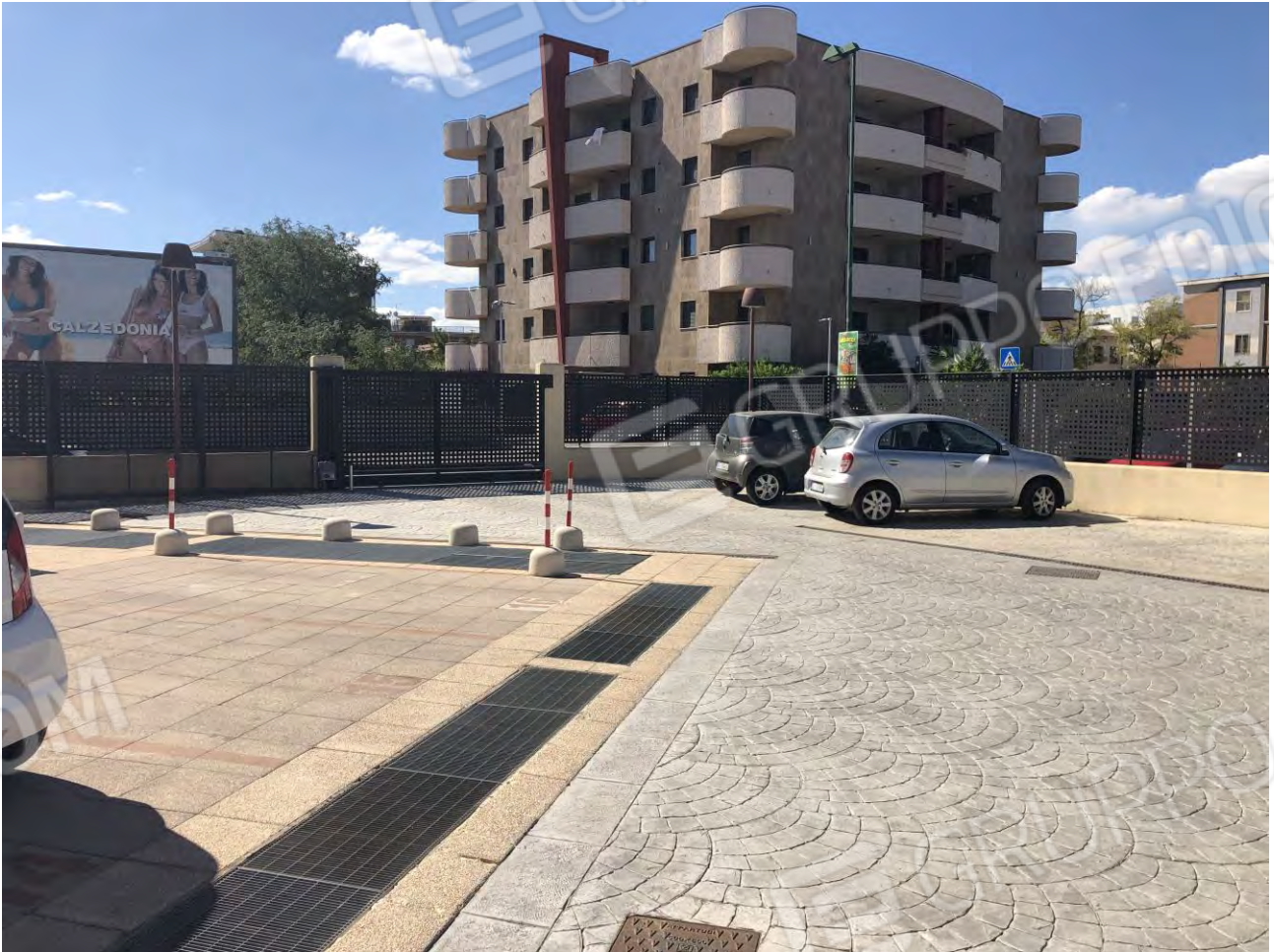
FOTO n. 03 – Vista area di parcheggio e accesso carrabile –
