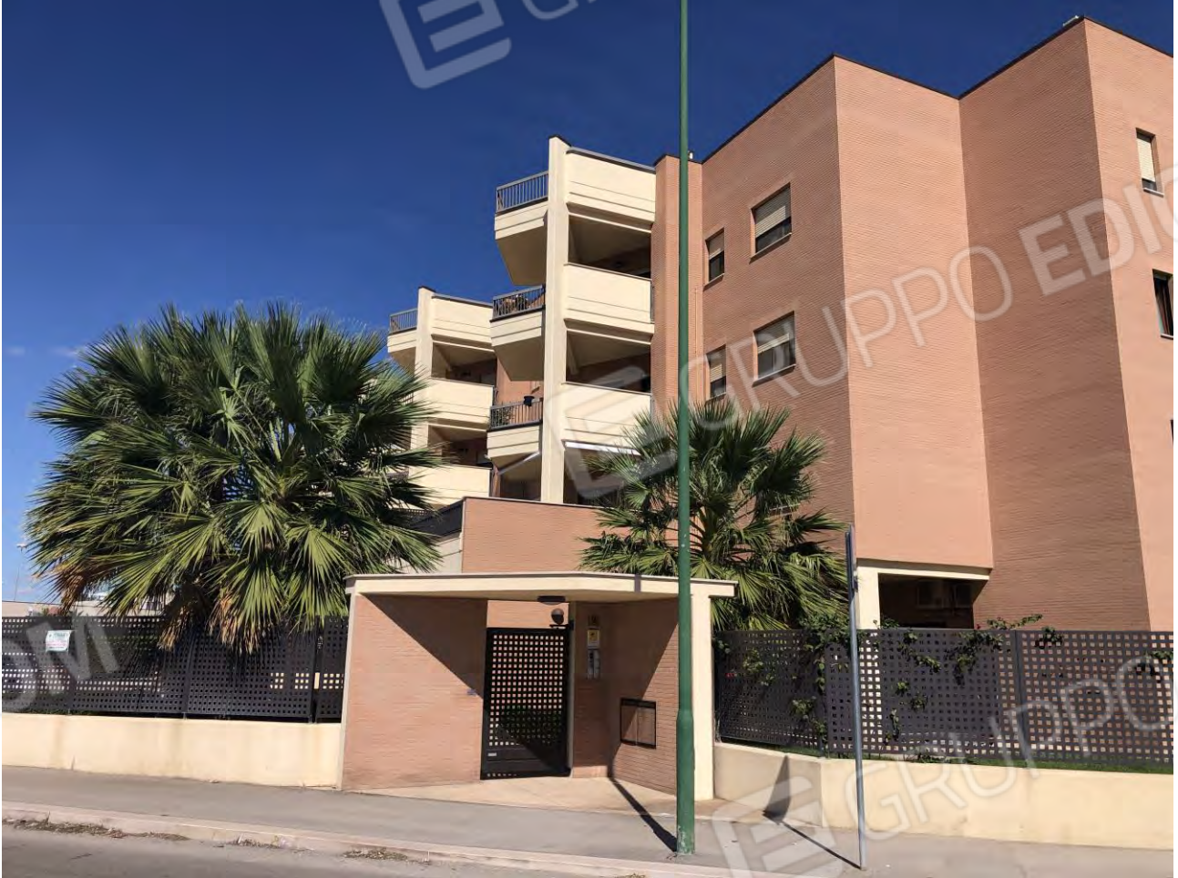
FOTO n. 01 – Prospetto Su Via L. Einaudi – Ingresso pedonale
