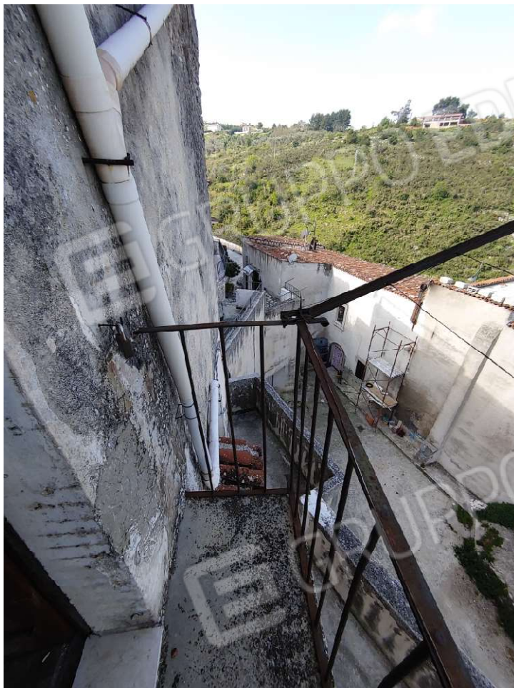
Foto C13 - LOTTO 1 - ABITAZIONE - BALCONE
