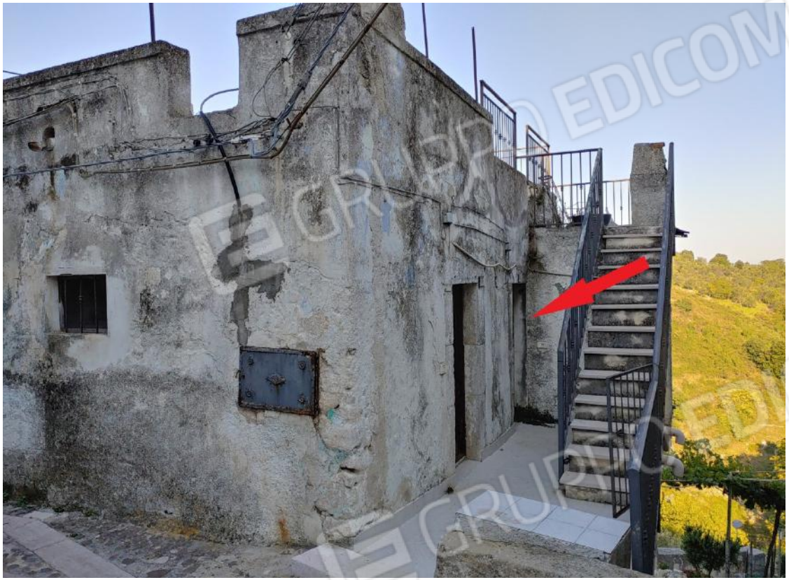
Foto C3 - LOTTO 1 - FABBRICATO - INGRESSO CIV. 33 DI VIA CASALE
