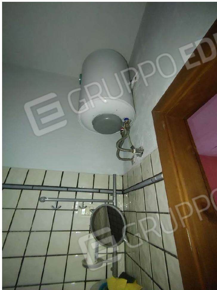
Foto C37 - LOTTO 2 - ABITAZIONE - BAGNO
