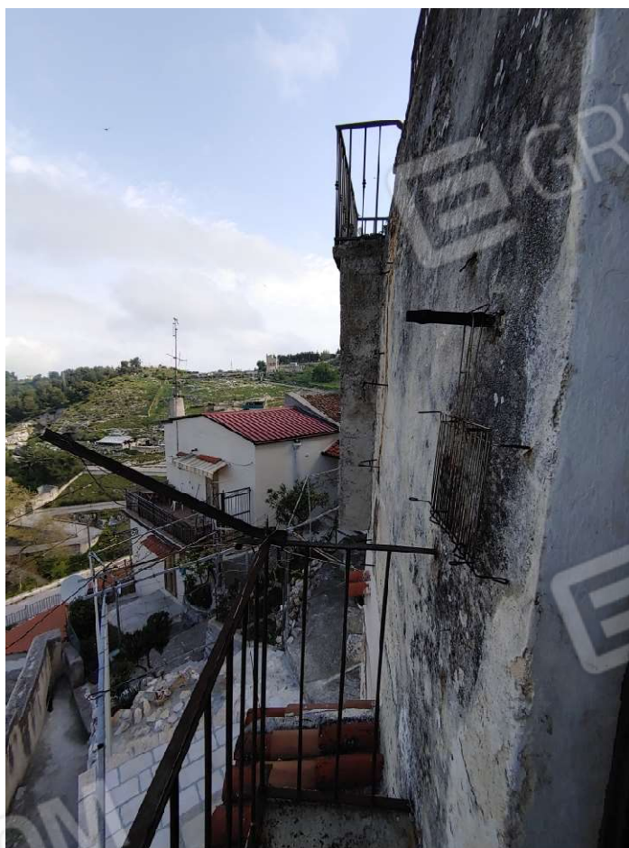
Foto C14 - LOTTO 1 - ABITAZIONE - BALCONE
