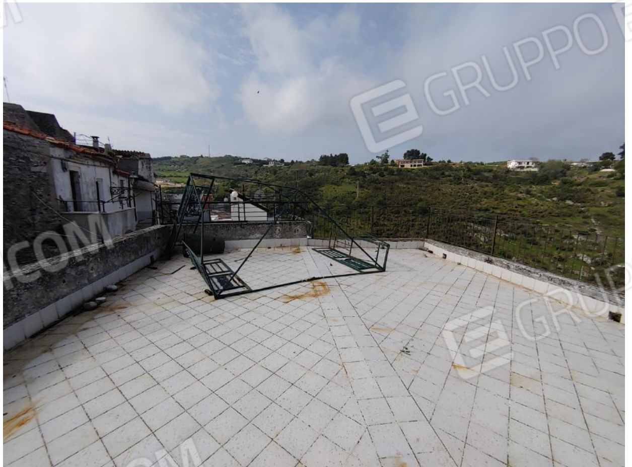
Foto C28 - LOTTO 2 - FABBRICATO - COPERTURA PRATICABILE
