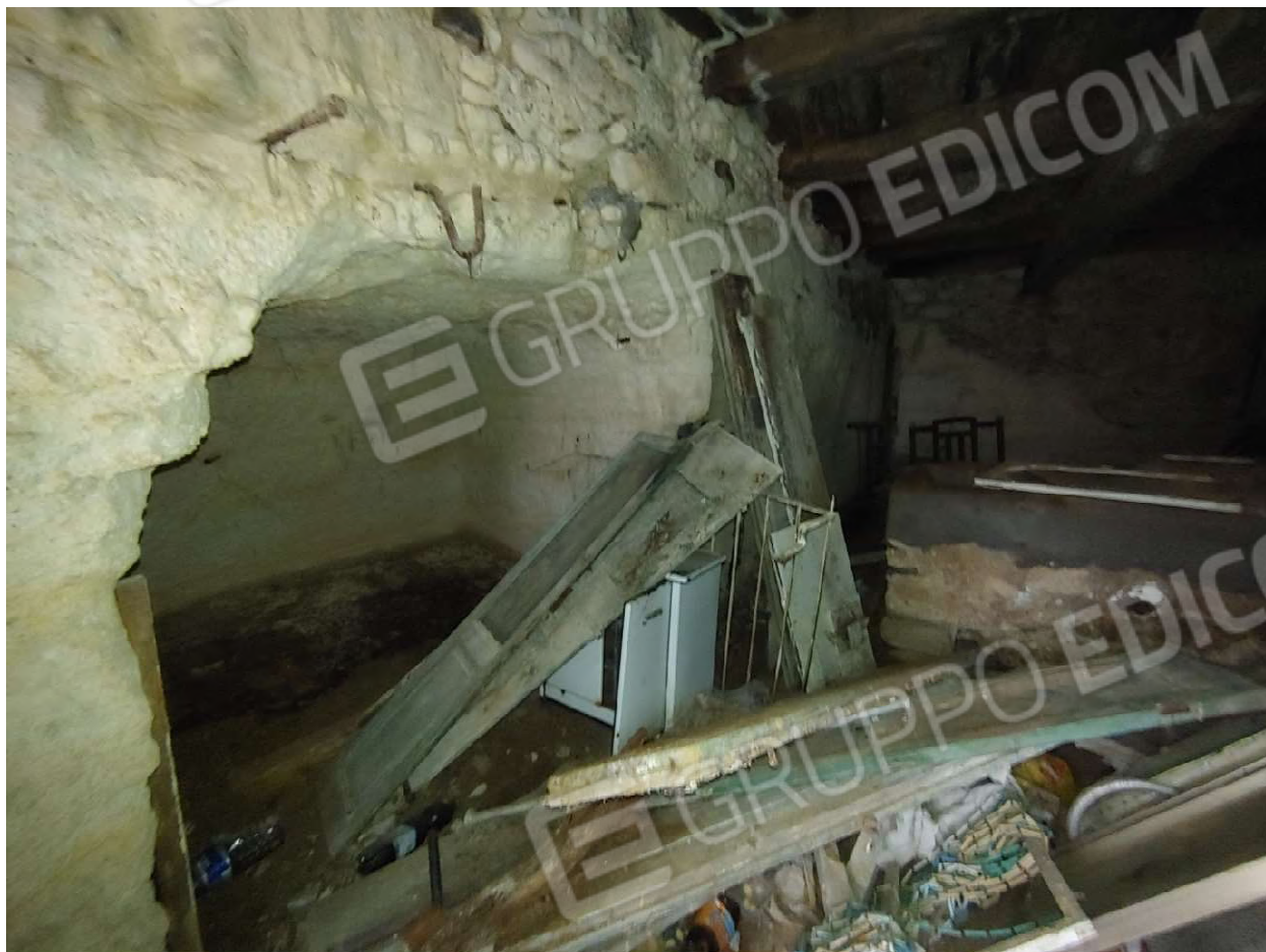
Foto C44 - LOTTO 3 - DEPOSITO -INTERNO
