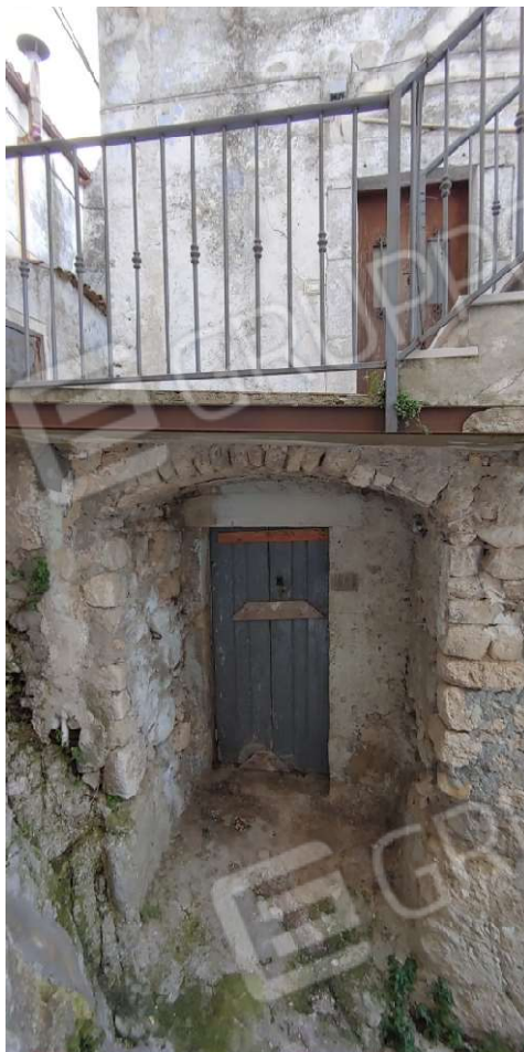
Foto C38 - LOTTO 3 - FABBRICATO - PROSPETTO SU VIA CASALE
