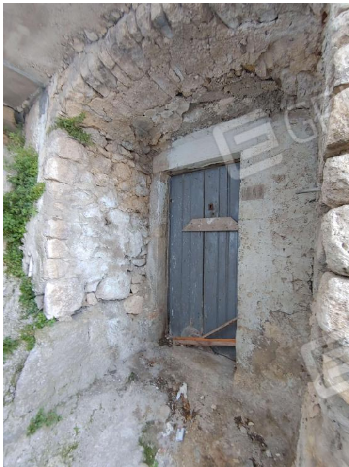
Foto C41 - LOTTO 3 - DEPOSITO - INGRESSO
