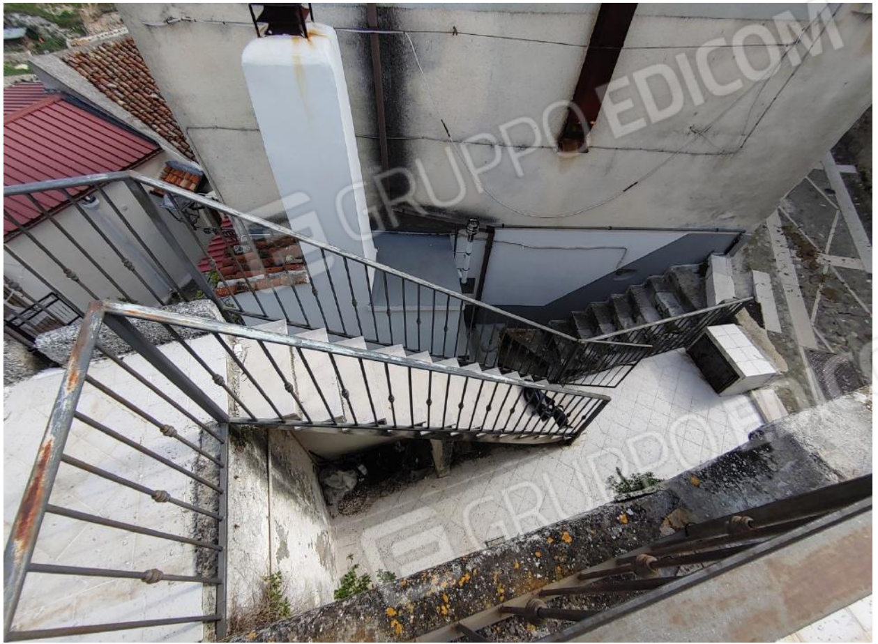
Foto C27 - LOTTO 2 - FABBRICATO - BALLATOIO/SCALINATA ESTERNA
