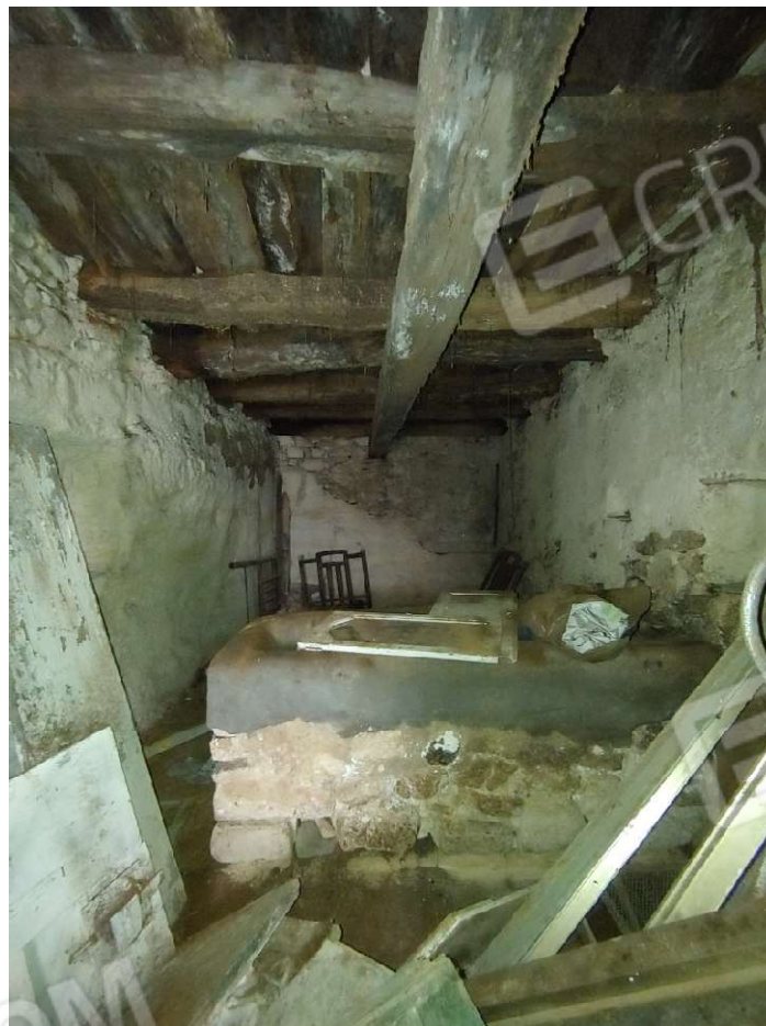
Foto C43 - LOTTO 3 - DEPOSITO - INTERNO
