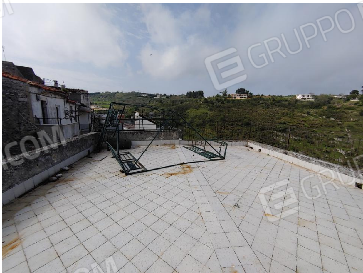
Foto C8 - LOTTO 1 - FABBRICATO - COPERTURA PRATICABILE
