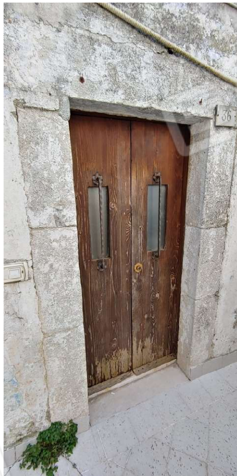
Foto C26 - LOTTO 2 - FABBRICATO - INGRESSO AL CIV. 36 DI VIA CASALE
