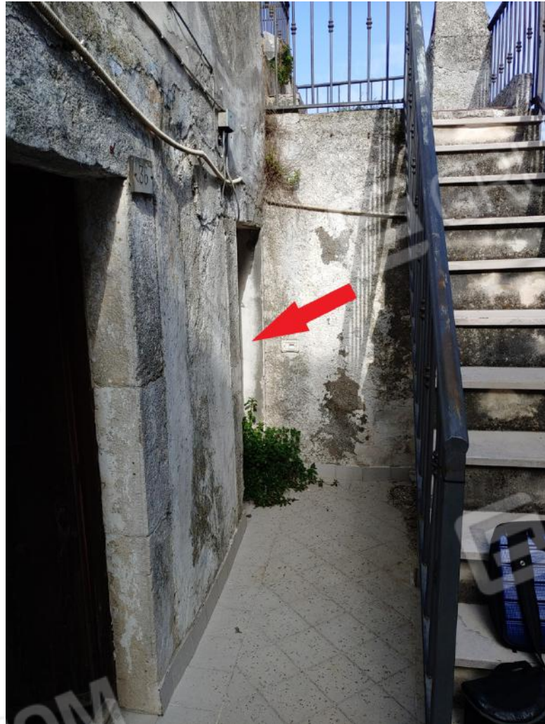
Foto C4 - LOTTO 1 - FABBRICATO - INGRESSO CIV. 33 DI VIA CASALE
