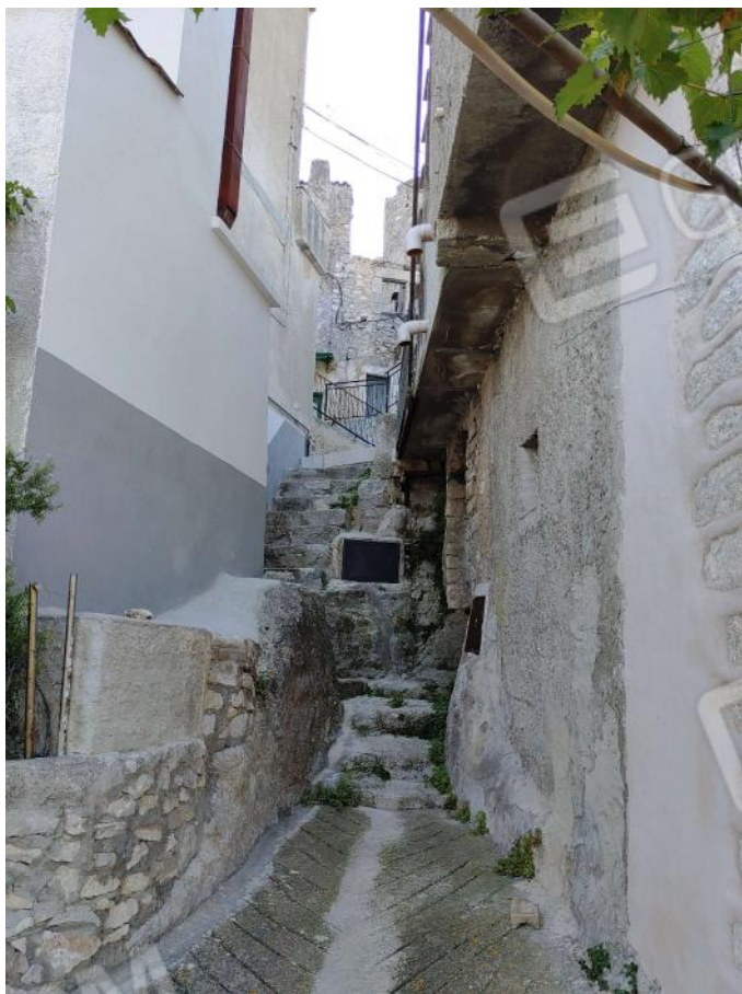
Foto C39 - LOTTO 3 - FABBRICATO - PROSPETTO SU VIA CASALE
