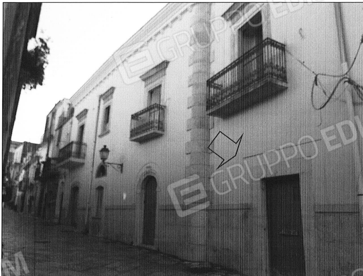
Figura 23. Accesso al civico 40 di Via Nazario Sauro che immette nell'unità immobiliare censita al foglio 39, p.lla 484, sub. 12 del comune di Apricena.
