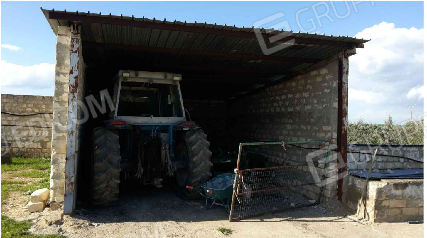
FOTO 4 - Corpo E1: tettoia
