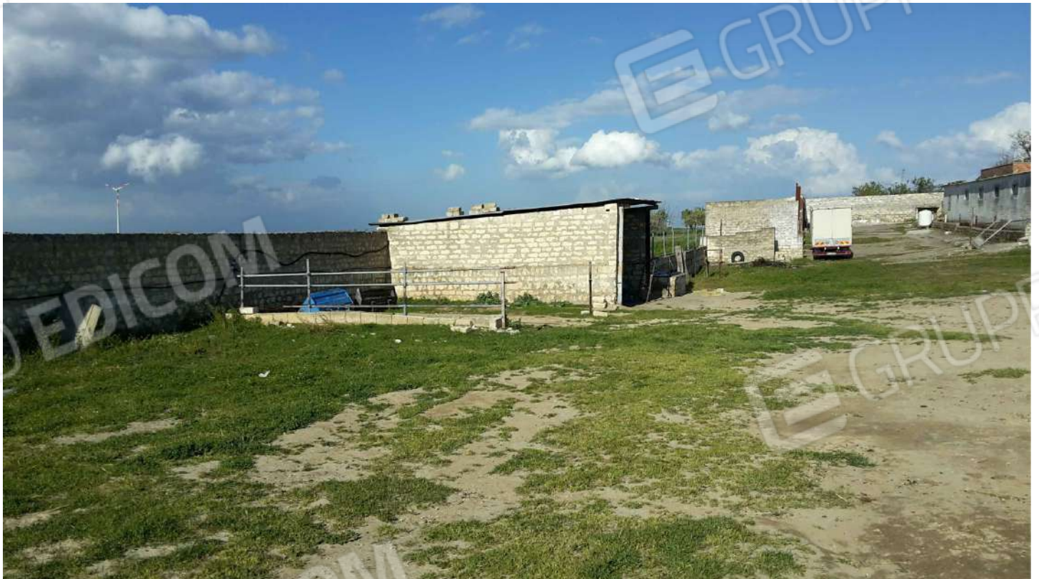
FOTO 2 - Corpo E1: tettoia
