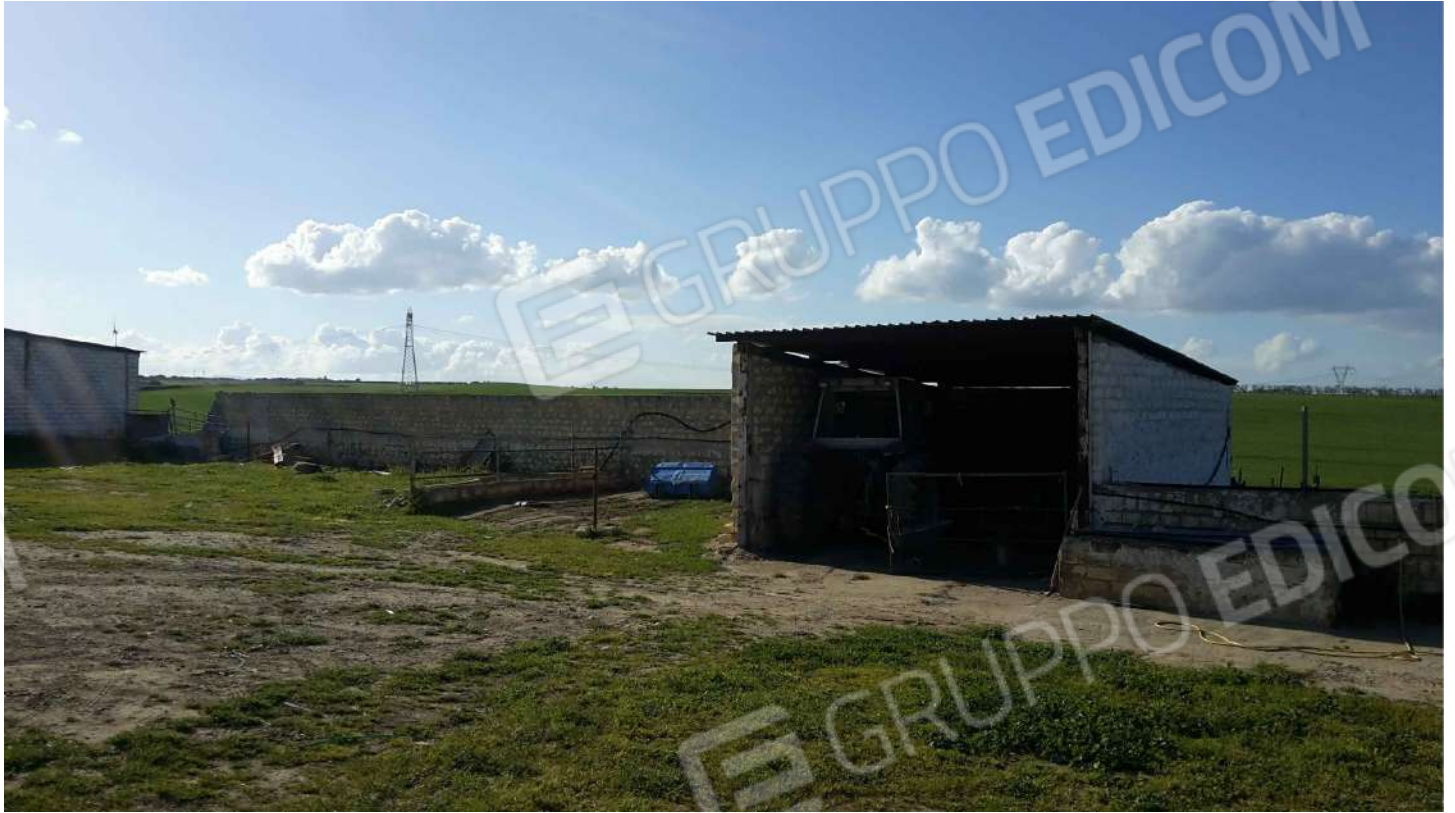
FOTO 1 - Corpo E1: tettoia
