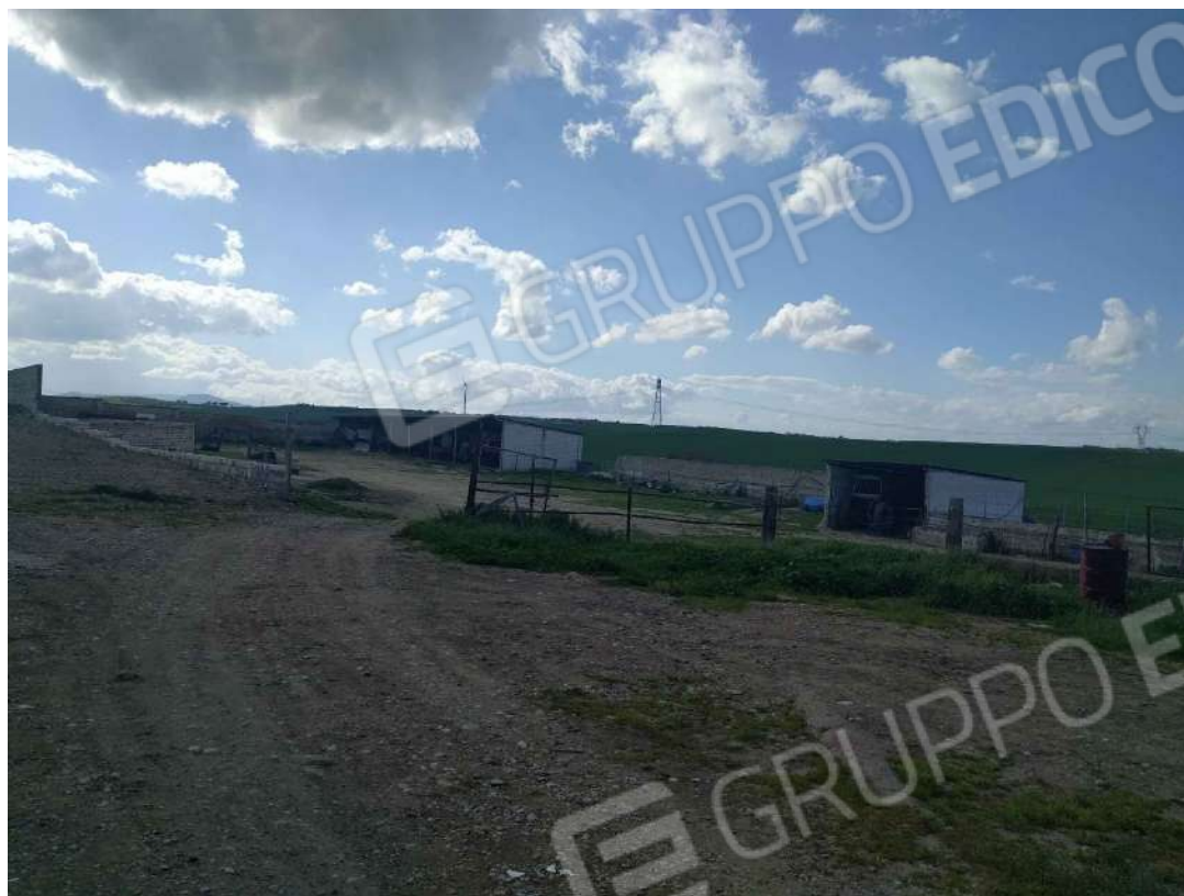
FOTO 1 - Veduta d'insieme del corpo E = ricovero animali (a sx) e del corpo E1 = tettoia (a dx)
