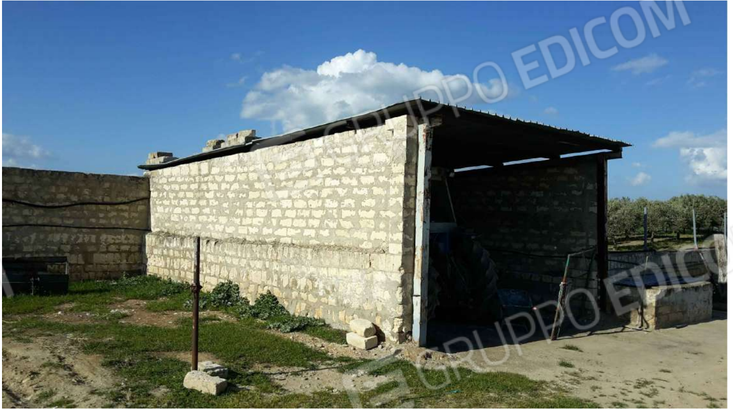
FOTO 3 - Corpo E1: tettoia
