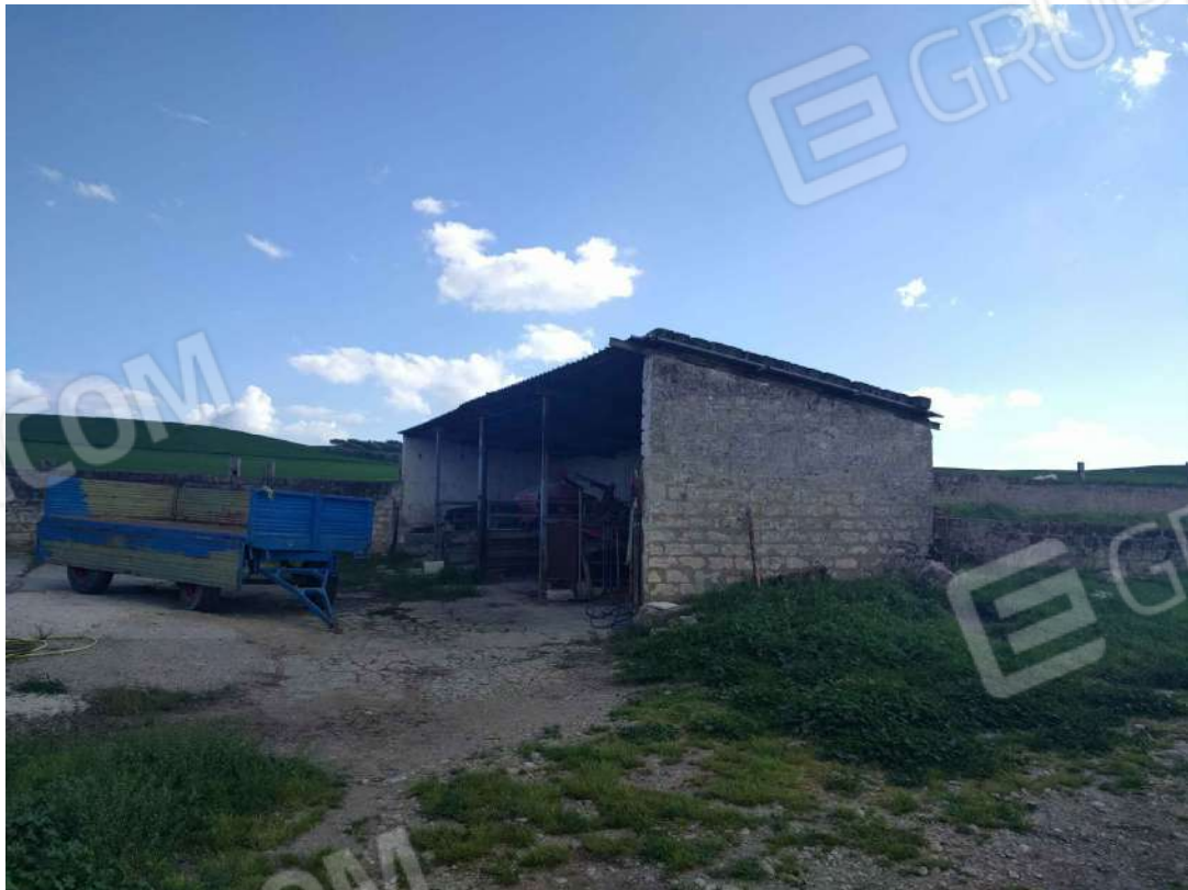
FOTO 2 - Corpo F: tettoia
