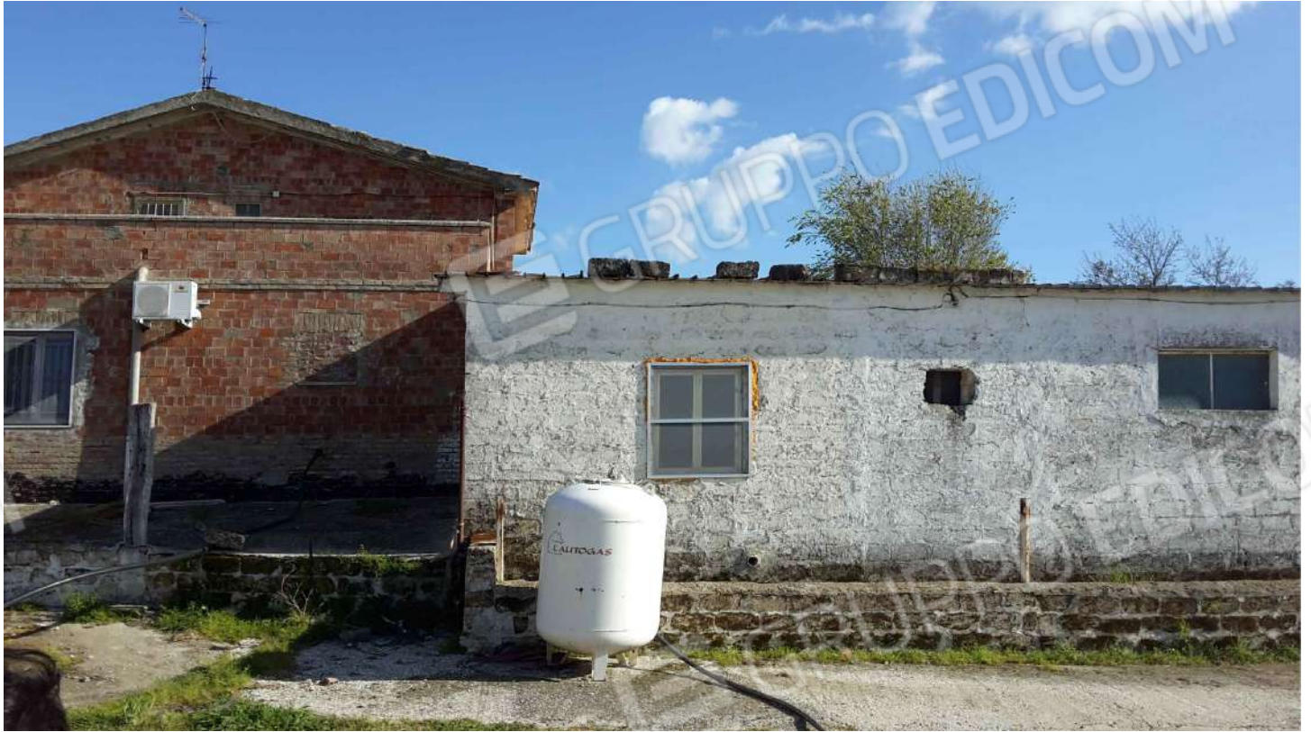
FOTO 19 - Corpo B = Stalla/Deposito macchine e attrezzi agricoli (a dx) e sub 2 (a sx)
