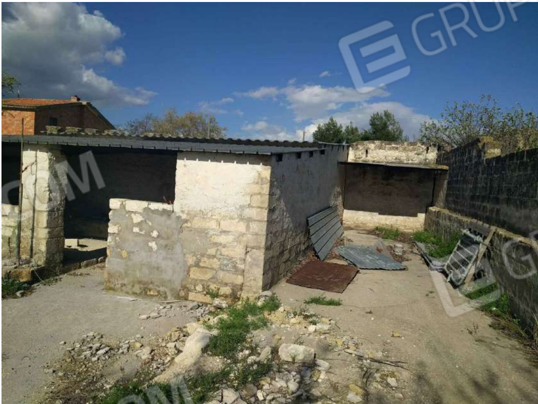
FOTO 6 - Corpo C = depositi/pollai: lato sud-ovest
