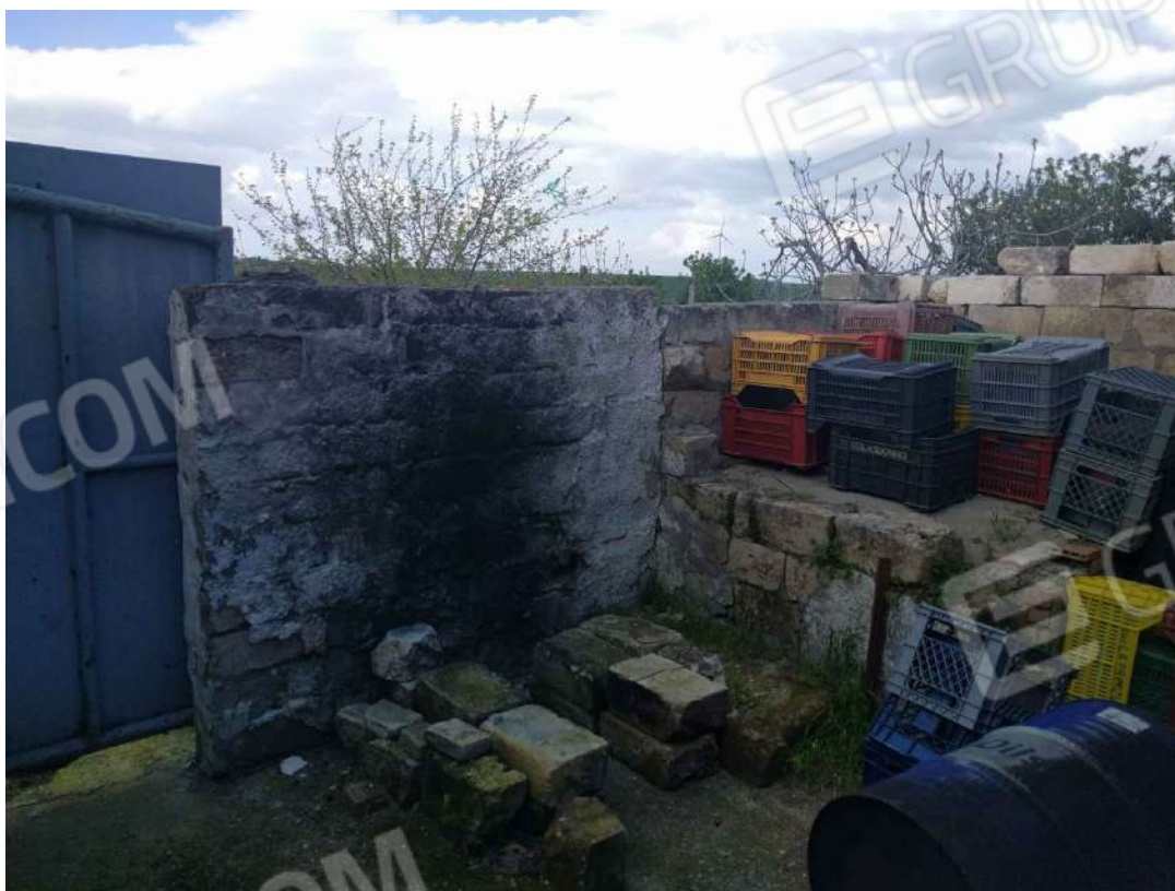
FOTO 4 - Vano 3: deposito attrezzi agricoli
