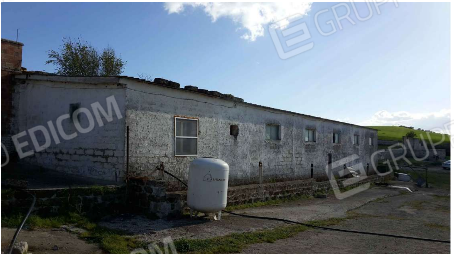
FOTO 18 - Corpo B = Stalla/Deposito macchine e attrezzi agricoli: lato nord
