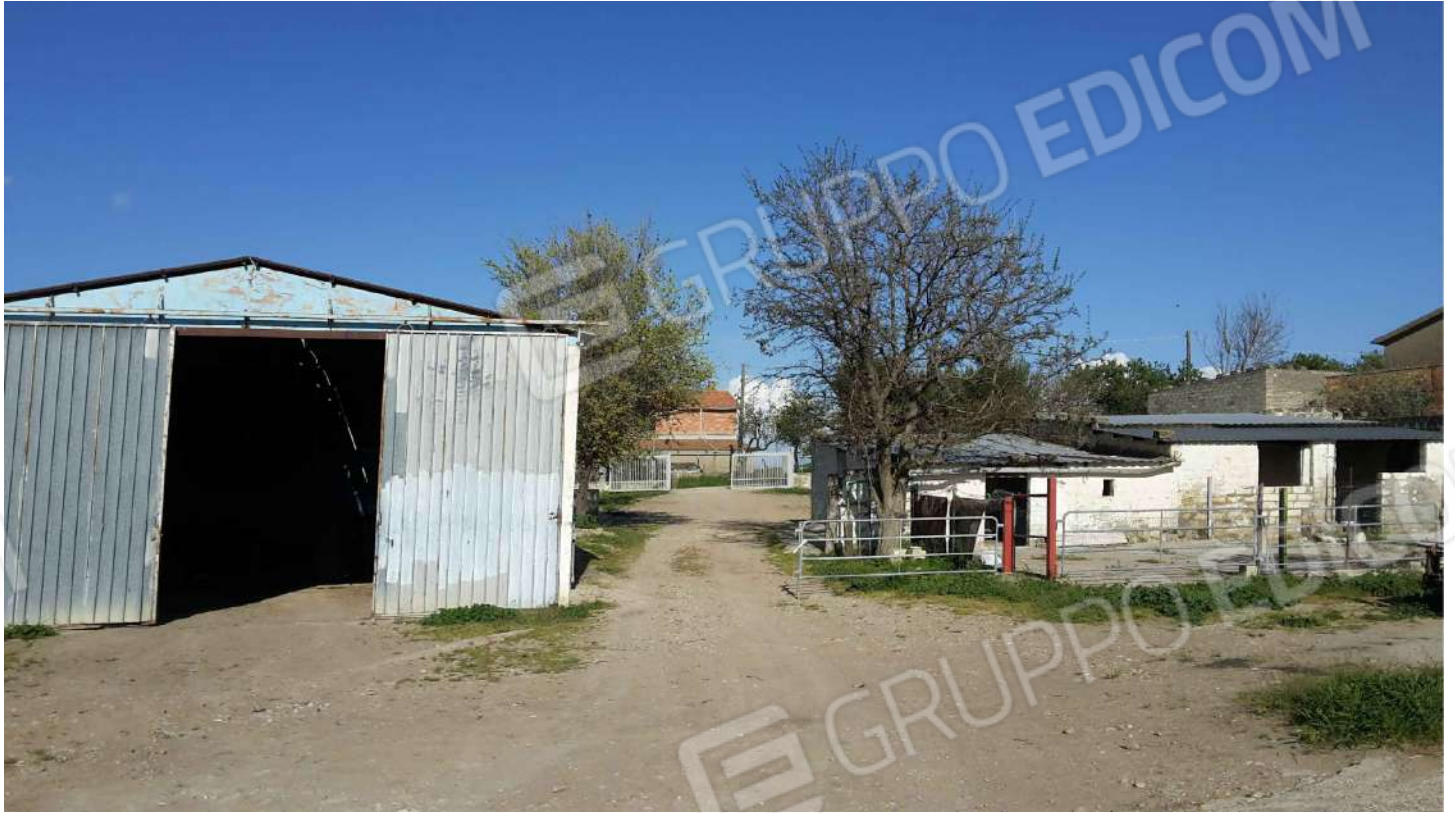
FOTO 13 - Vano 4: deposito macchine e attrezzi agricoli
