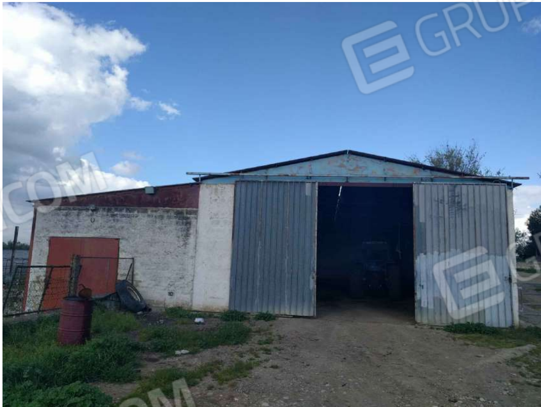
FOTO 14 - Prospetto del corpo B : Vano 3 = stalla; Vano 4 = deposito macchine e attrezzi agricoli da sud-ovest
