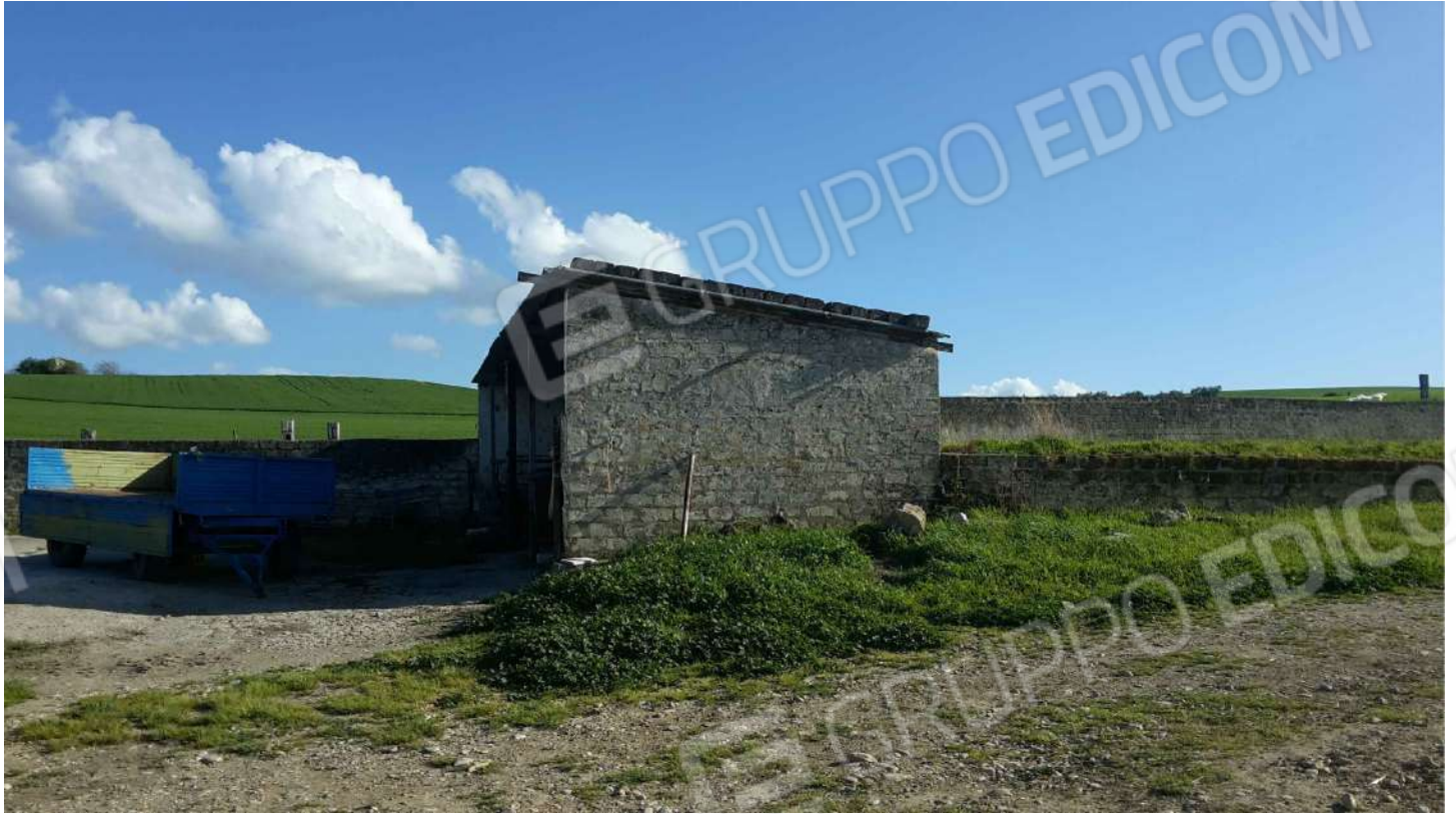
FOTO 1 - Corpo F: tettoia
