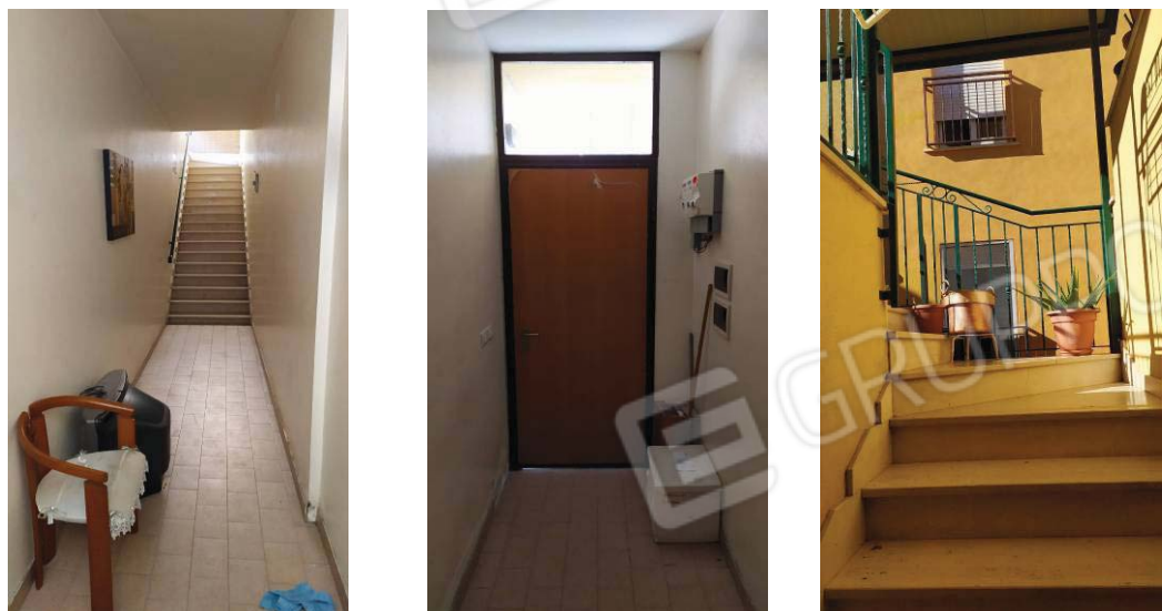
FOTO N° 3-4-5 – Vista dell'androne di ingresso e della scala.
