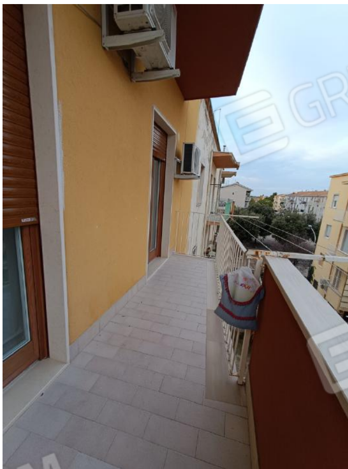
Foto C10 - LOTTO 1 - ABITAZIONE AL TERZO PIANO - BALCONE AD EST
