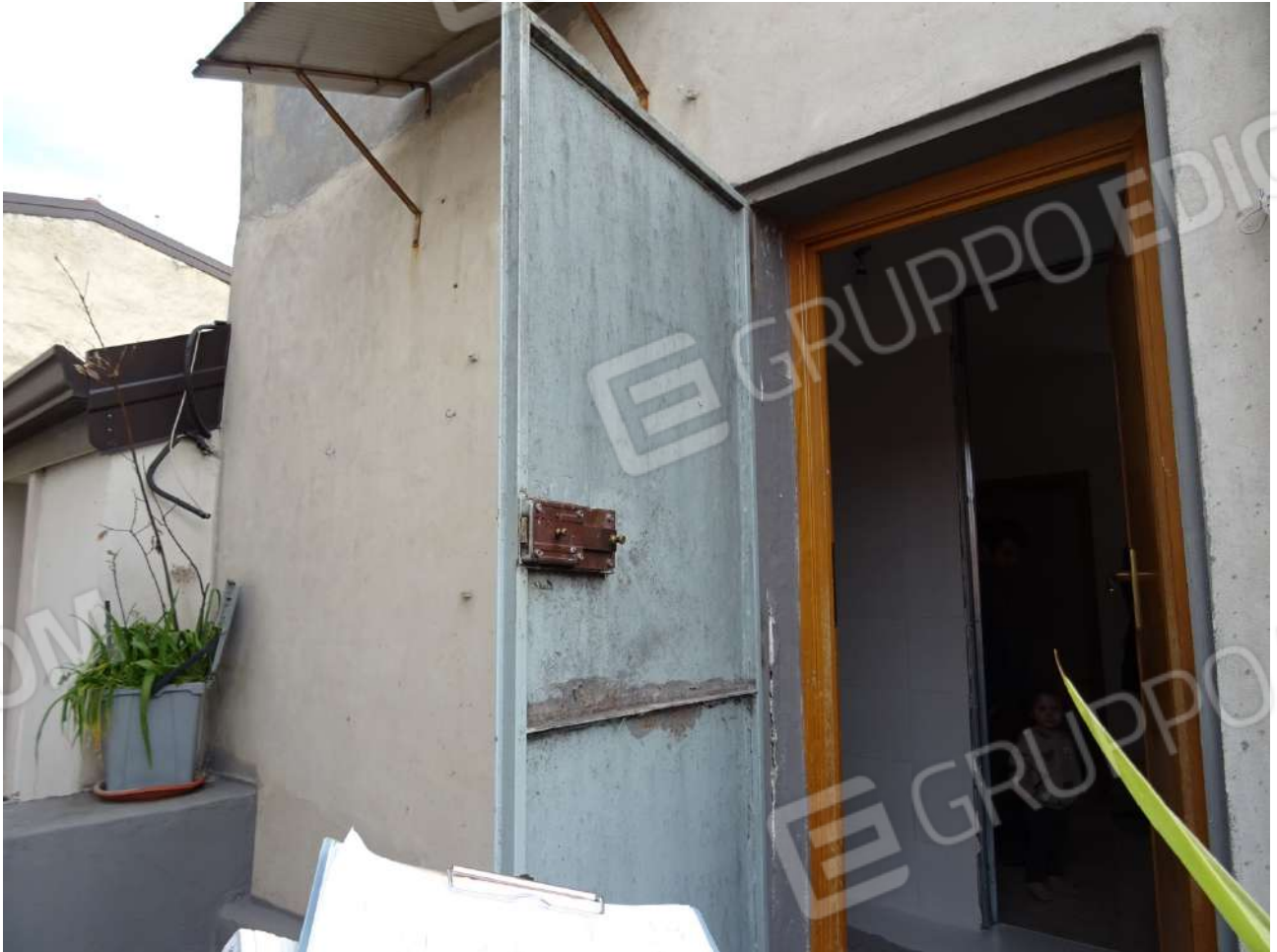
Porta di accesso al piano di copertura esterno
