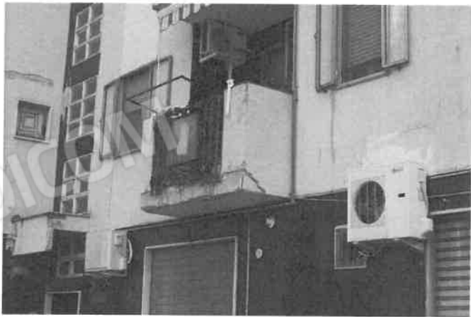
Foto n°6 Il portone di ingresso con la sua pensilina
