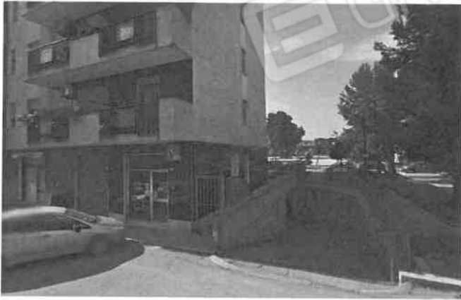
Foto n°4 la rampa di accesso al iano interrato
