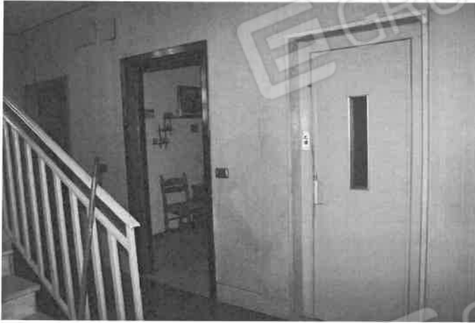
Foto n°10 La porta di ingresso all'unità abitativa in esecuzione, a sinistra di quella dell'ascensore.
