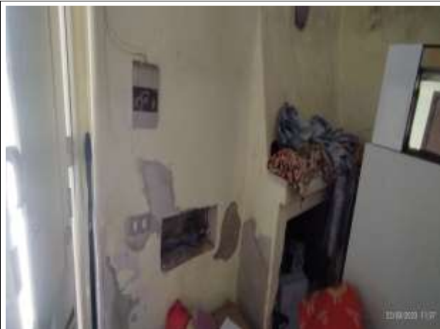
Foto 3 vano piano terra
