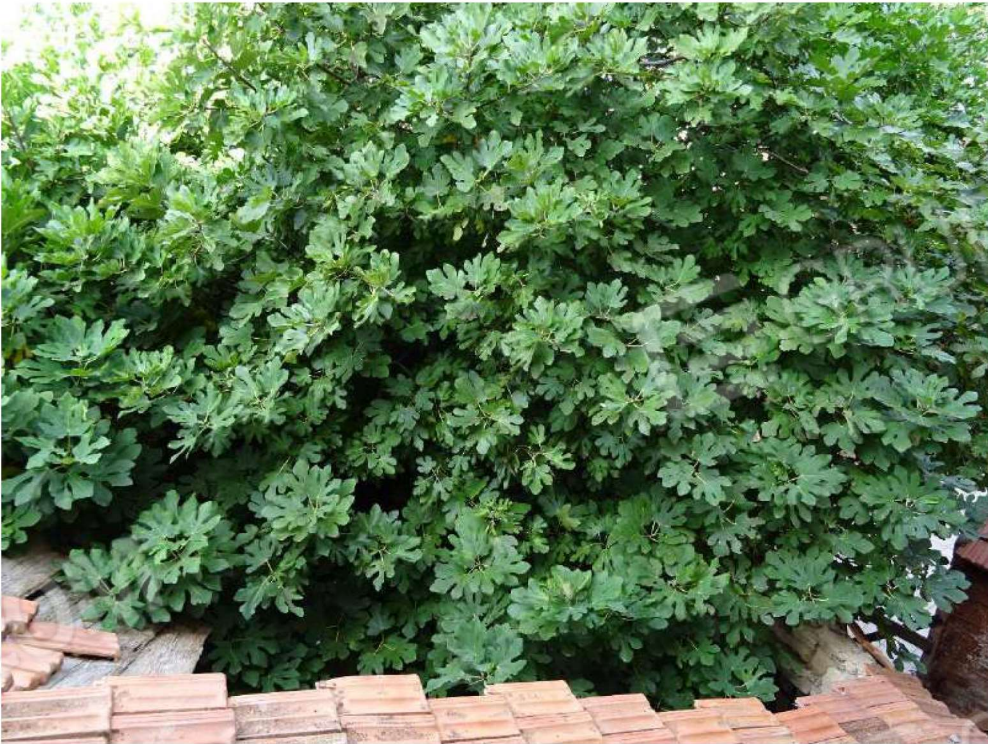
Foto n. 18 Particolare Vegetazione arborea cresciuta interno immobile p.lla 2484
