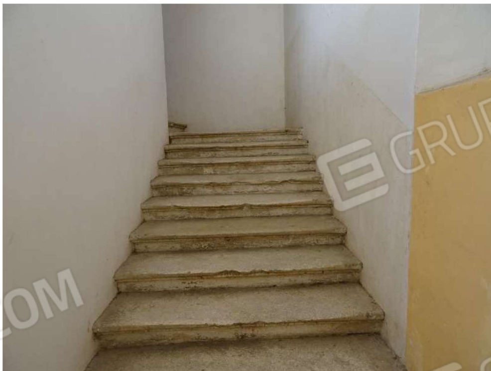
Foto n. 6 Rampa di scale
