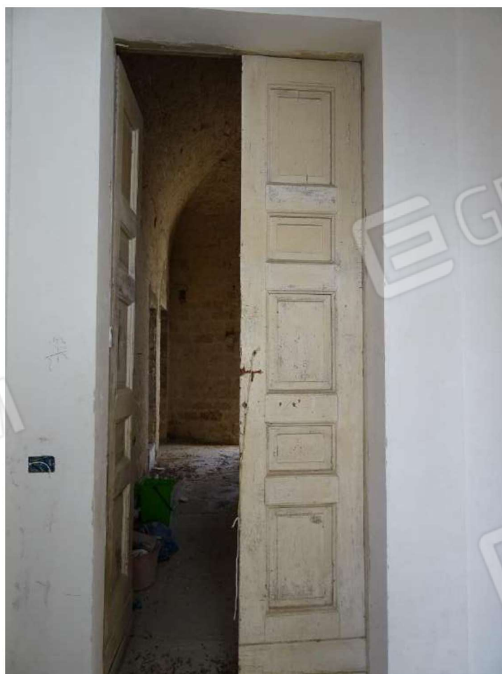
Foto n. 8 Porta di ingresso
