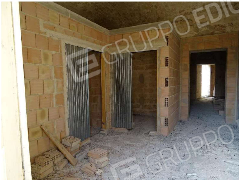
Foto n. 23 Interno camera da letto verso bagno e ripostiglio
