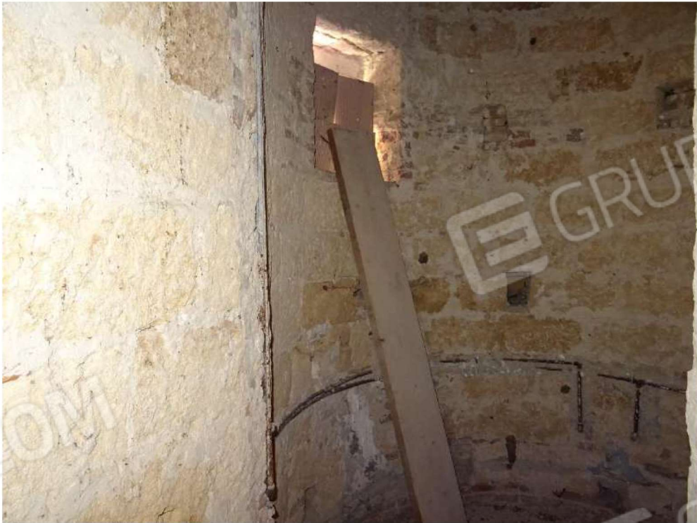
Foto n. 14 Bagno presente all'interno della 1° stanza
