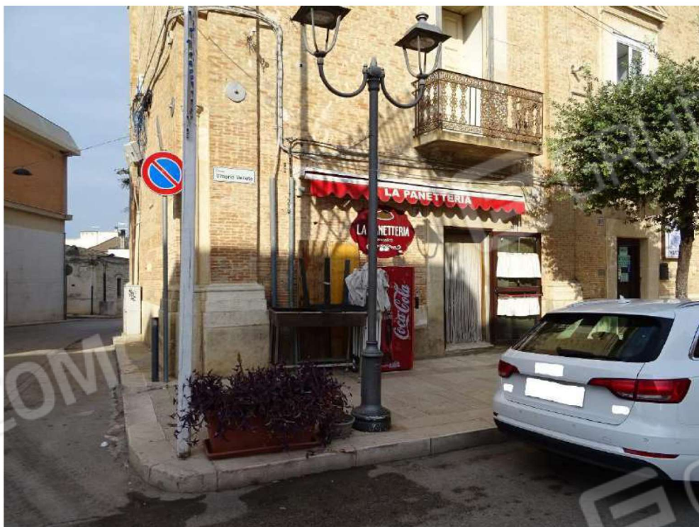
Foto n. 2 Foto Prospetto C.so Vittorio Veneto n. 8
