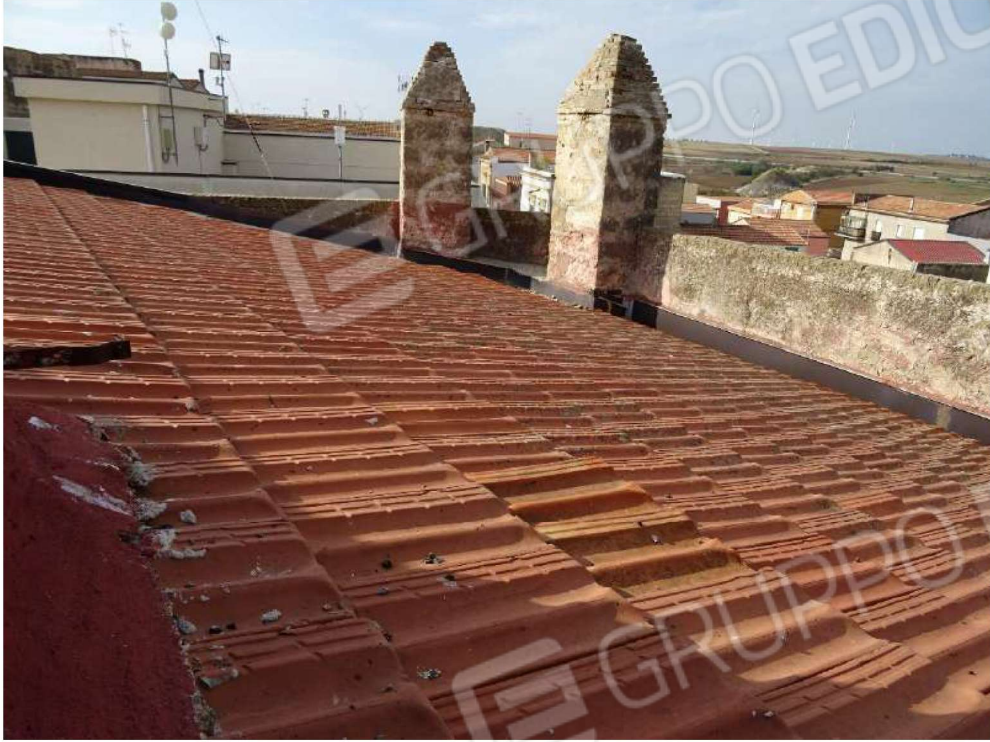
Foto n. 29 Copertura a falda inclinata con tegole marsigliesi
