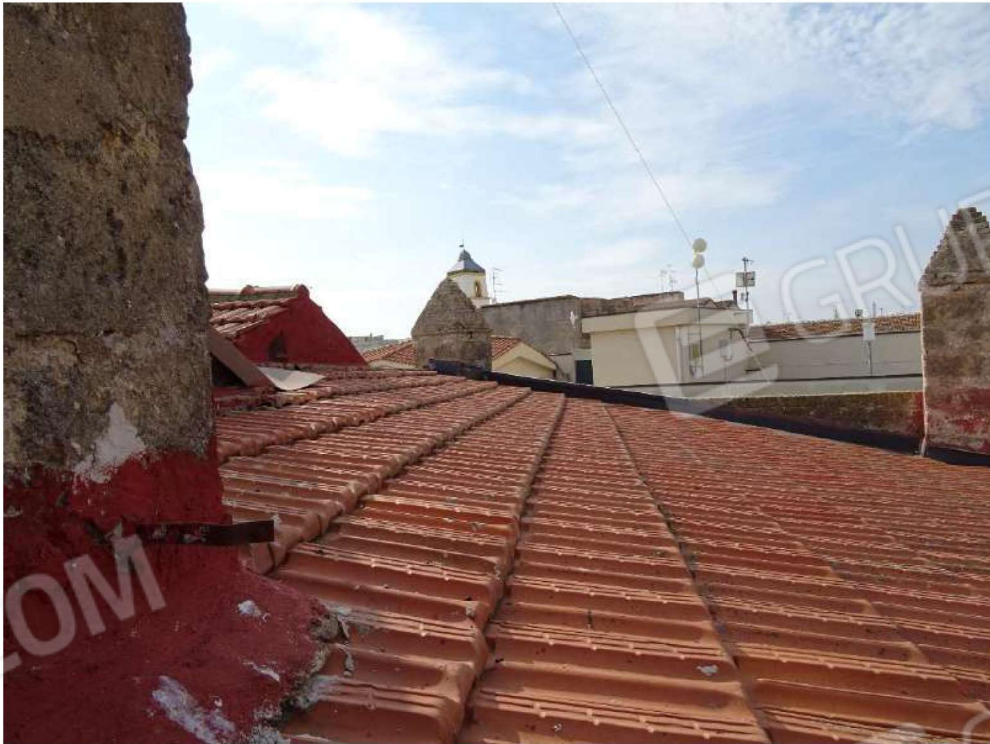
Foto n. 30 Copertura a falda inclinata con tegole marsigliesi
