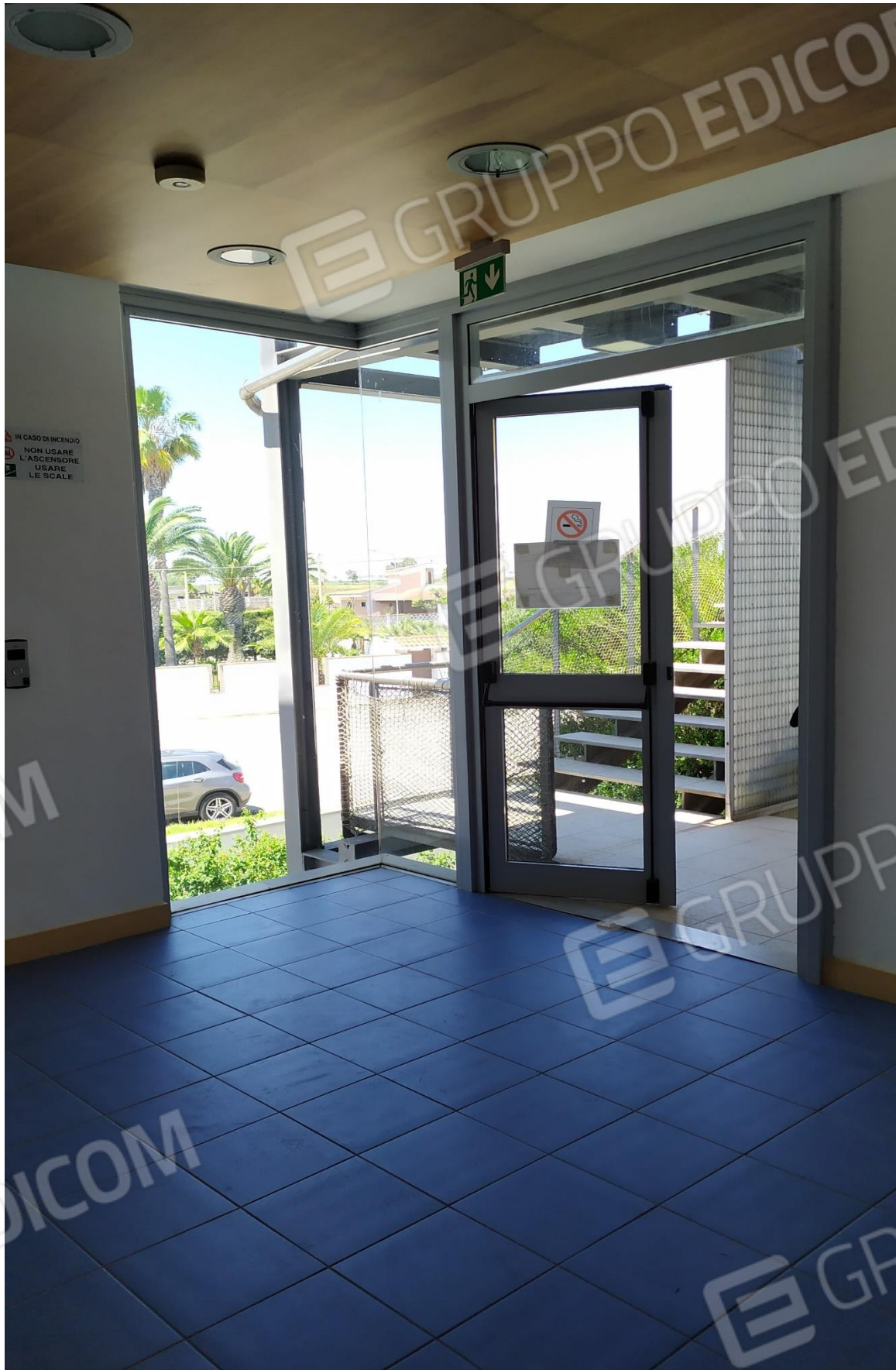
FOTO I.97: in evidenza, il pianerottolo di disimpegno ascensore, le ampie vetrate con uscita di sicurezza e vista sul patio, la scala esterna di accesso al piano superiore ed inferiore, nonché di sicurezza.
