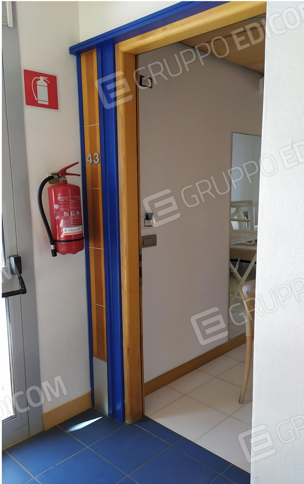
FOTO I.115: in evidenza, la camera 43, pressoché identica alle altre camere dell'Hotel.
