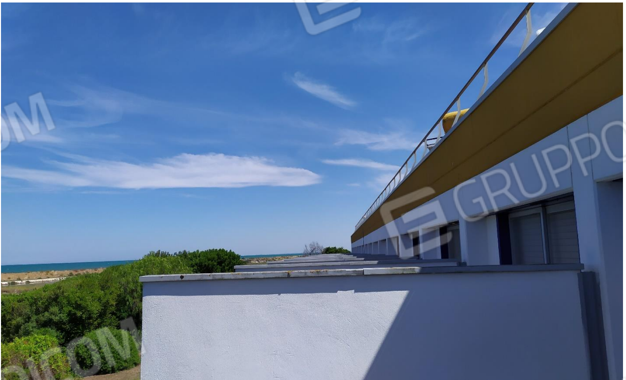
FOTO I.129: in evidenza, i setti divisori delle verande.
