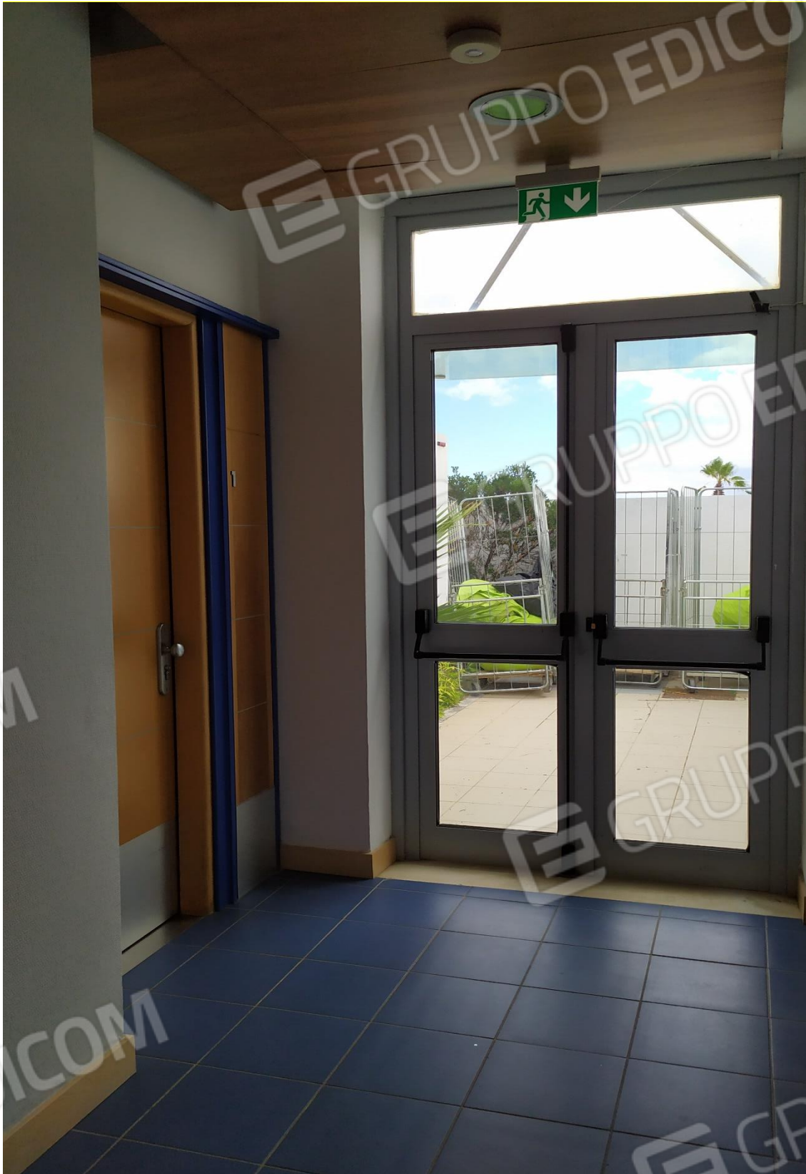
FOTO I.44: in evidenza, il corridoio di disimpegno in prossimità della camera 1.
