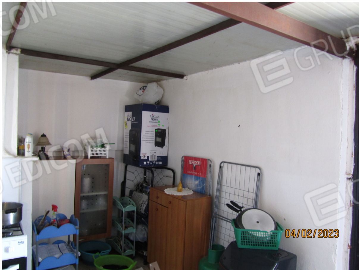
FOTO N. 22 – IDEM C.S. – VISTA INTERNA.
