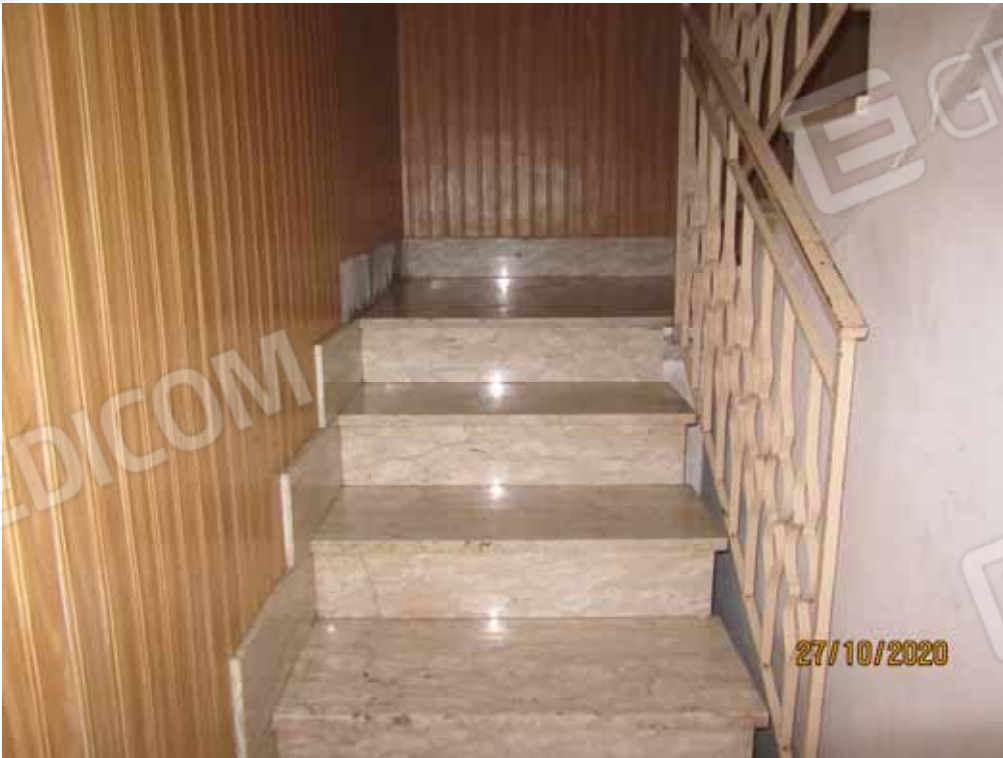
FOTO 4 – Vano scala (1 a rampa).
