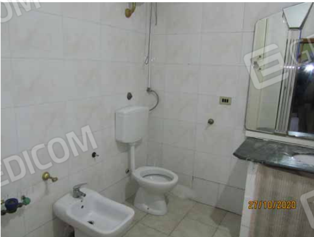
FOTO 8 – Bagno – particolare articoli sanitari.
