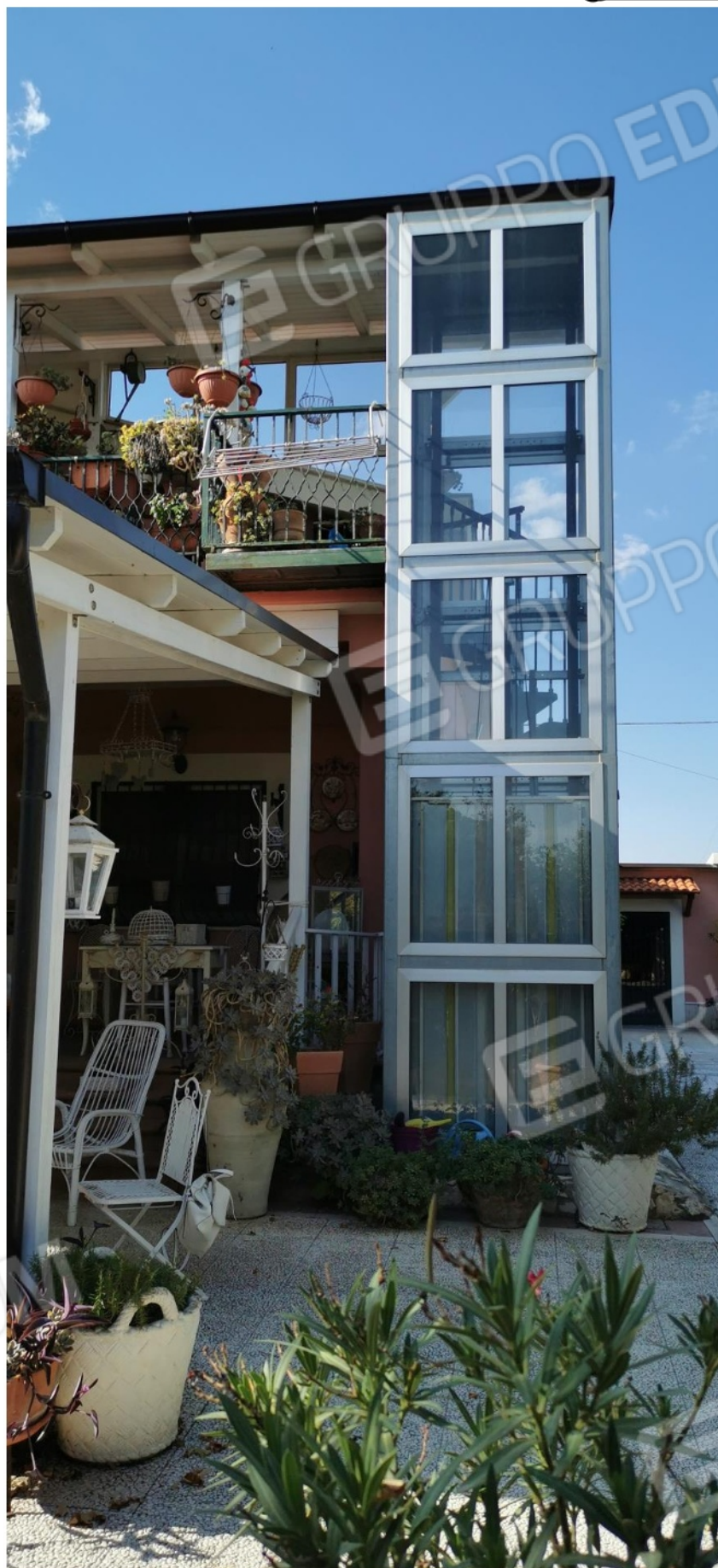
Figura 16: immobile in Lucera (FG) c.da Conocchiola snc (viste esterne)
