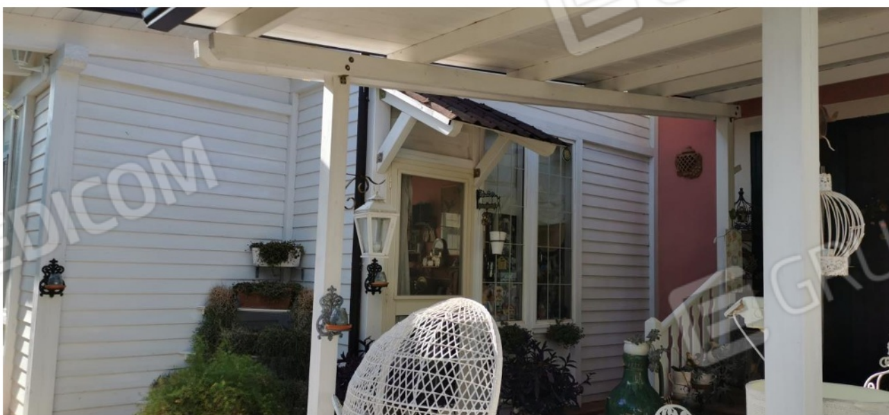
Figura 17: immobile in Lucera (FG) c.da Conocchiola snc (viste esterne)
