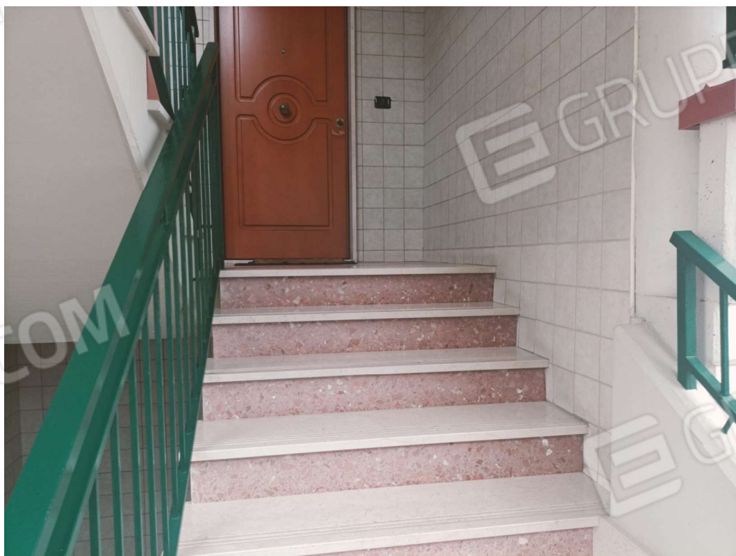
Scalinata d'accesso all'immobile
