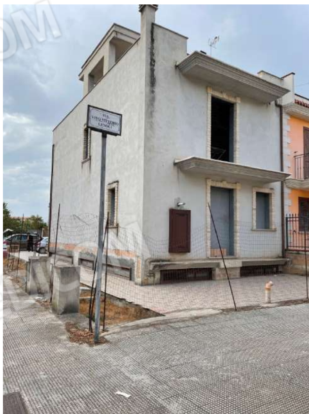
Figura 4. LOTTO UNICO: Fabbricato unifamiliare in cui si trovano gli immobili pignorati al F. 8, P.IIa 3929, Sub. 1 e 2 ubicati in San Ferdinando di Puglia (BT) alla Via V. Bachelet n. 2 e 4 (facciata prospiciente la Via V. Lenoci).
