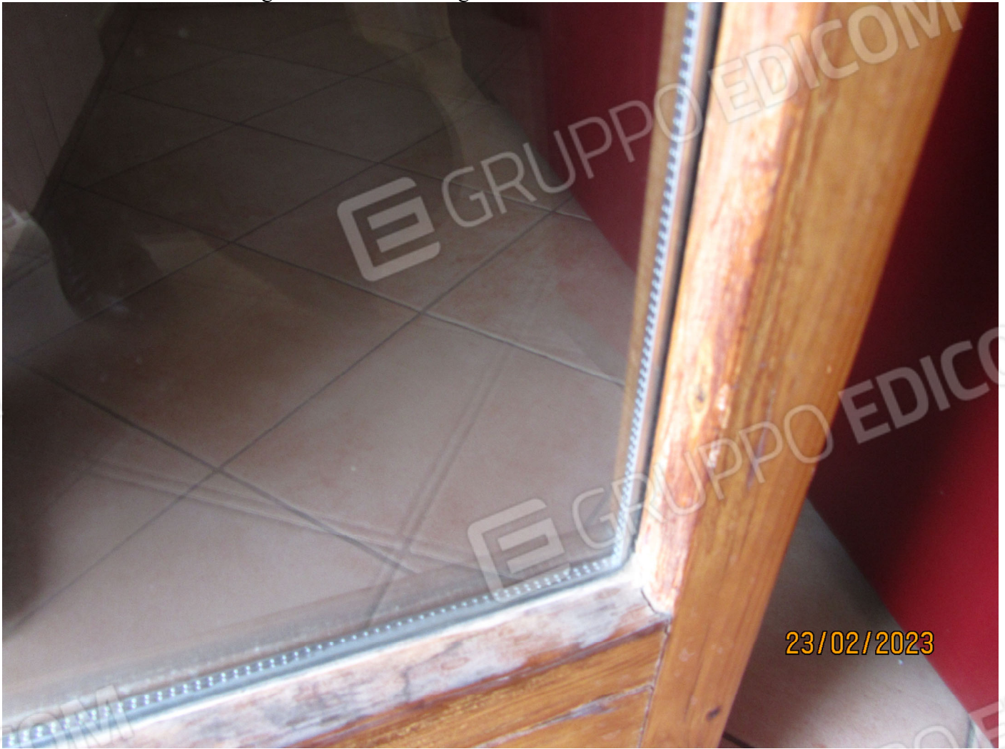
FOTO N.15 – Particolare degli infissi interni in legno.
