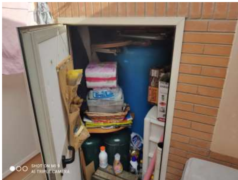
Particolare del terrazzo
