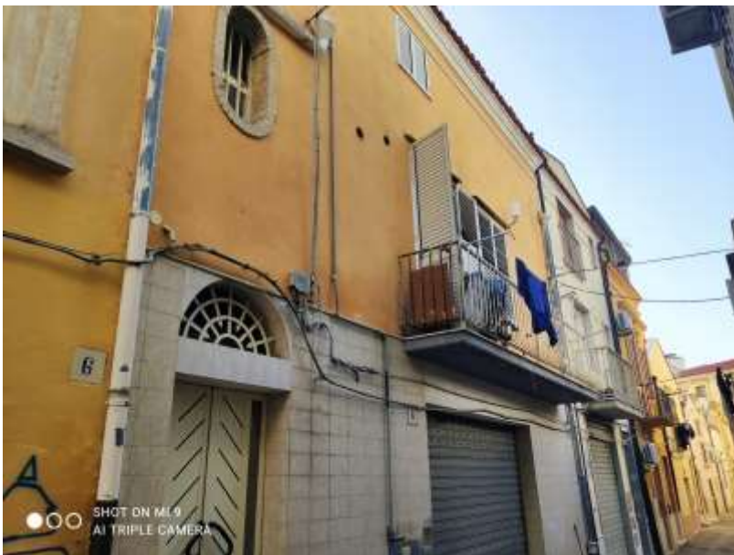
Vista dell'accesso al civico Via Arco 6
