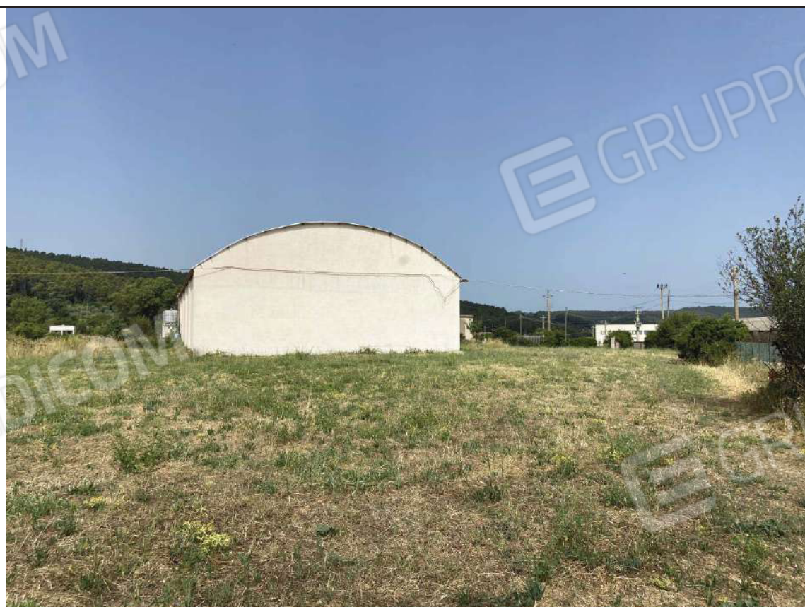
Foto 5) – Vista su prospetto retro IMMOBILE A
