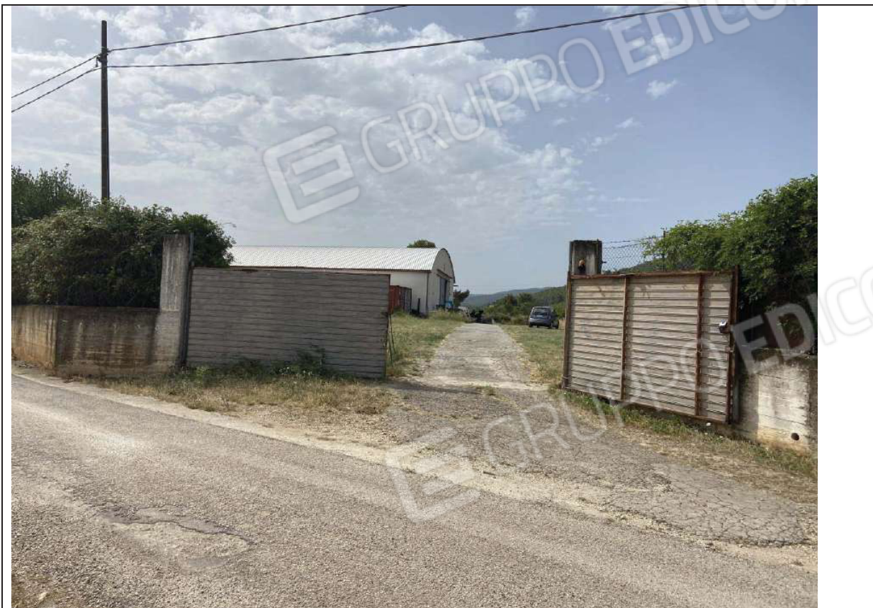
Foto 1) – Ingresso IMMOBILE A e B dalla strada
