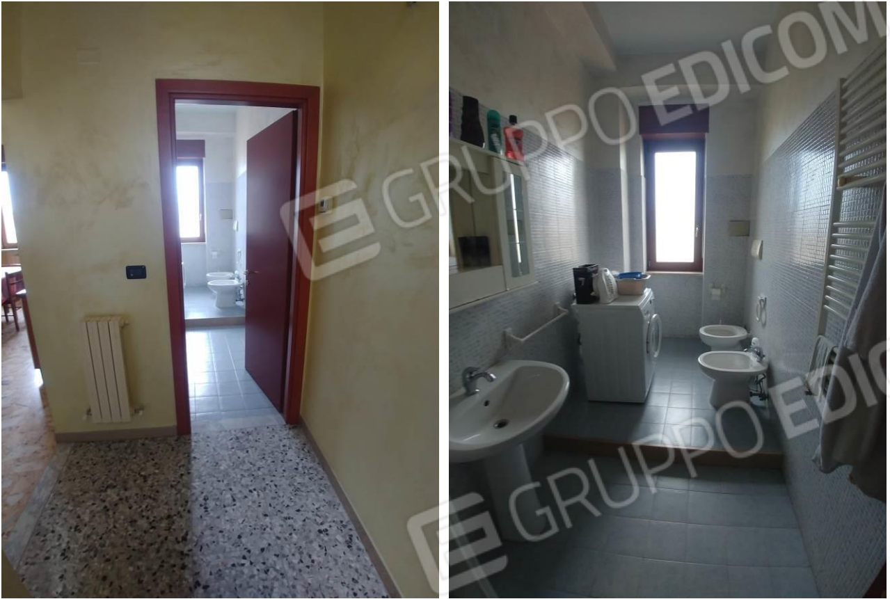
Figura 13: interno appartamento (WC)
