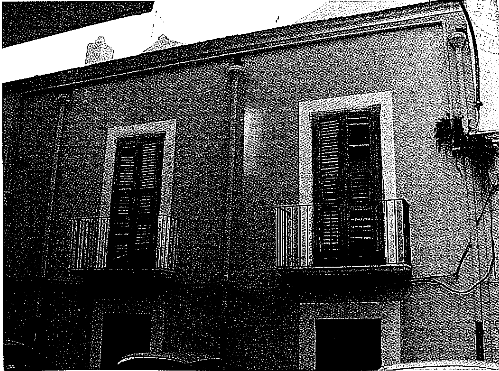
Foto n. 10 - Facciata da Vico Freccia (piano 1°)
