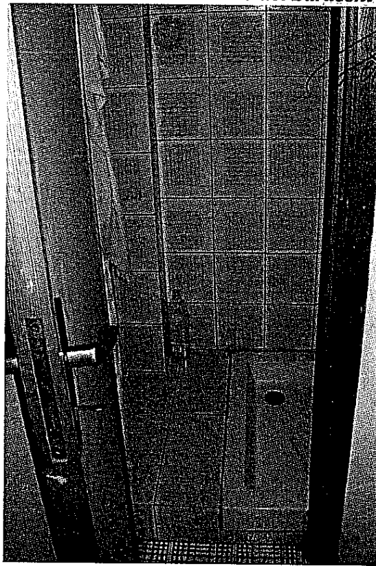
Foto n. 23 – Vista del locale doccia
