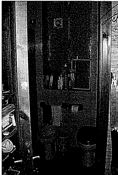
Foto n. 7 – Vista del bagno
