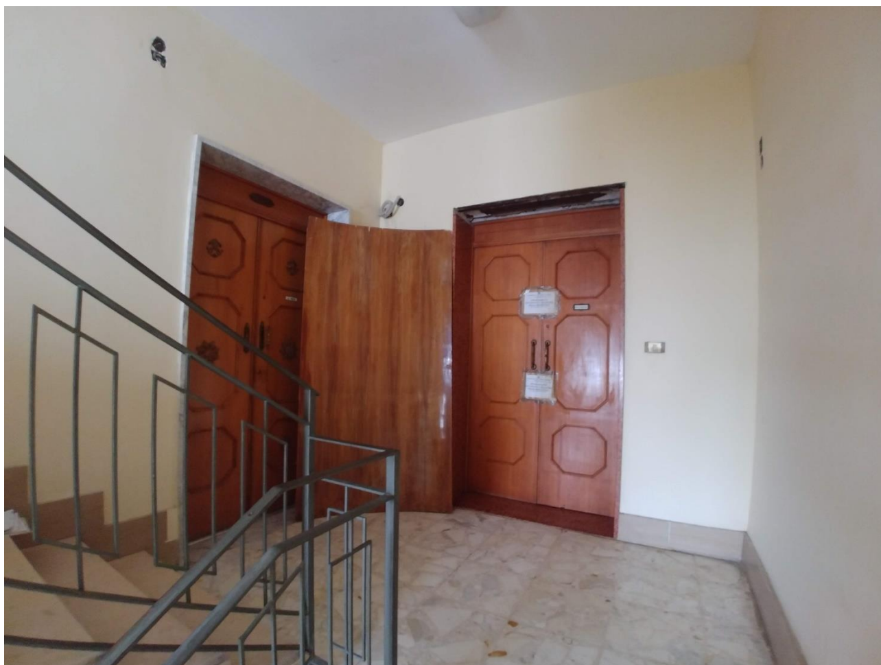
Figura 6: appartamento in via Porta Foggia,132 piano 1^ (scala condominiale) sopralluogo del 13/07/2019
