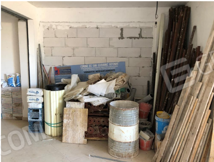
Foto n. 4: Ingresso murato del sub. 28
