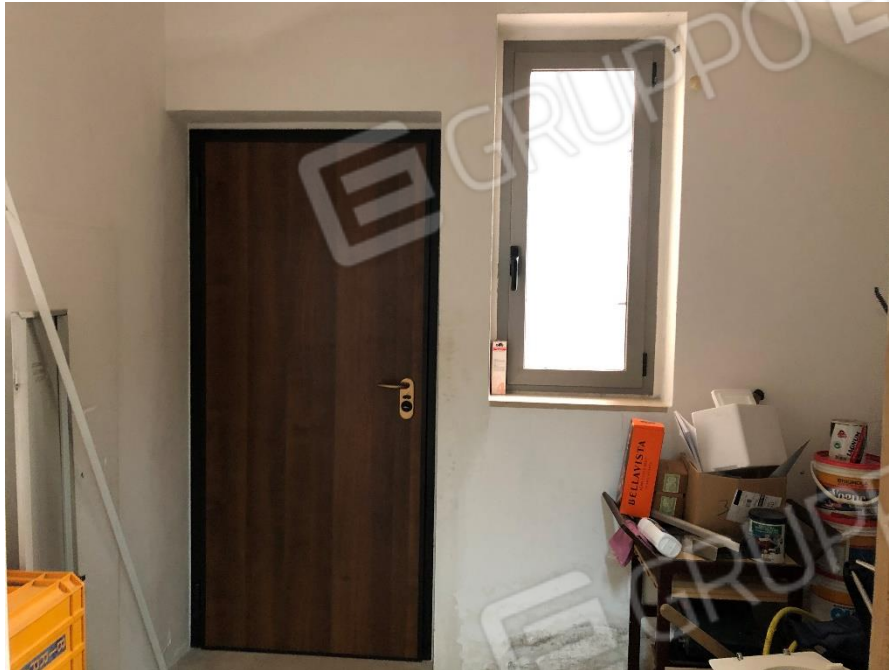
Foto n. 7: Porta di collegamento con la corte esterna a piano terra
