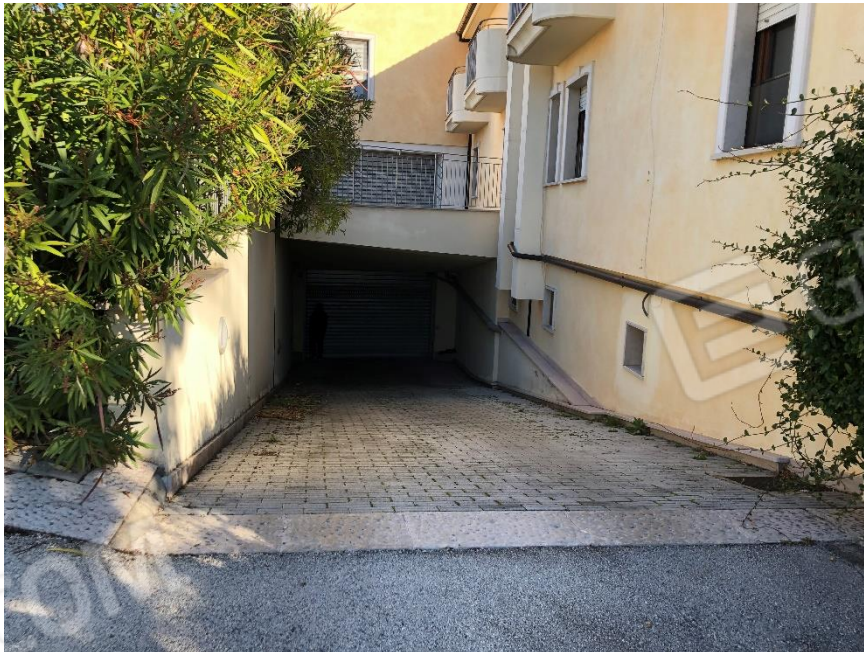
Foto n. 2: Ingresso bene oggetto di stima piano primo sottostrada
