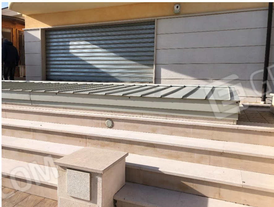
Foto n. 12: Corte di pertinenza del sub. 28
