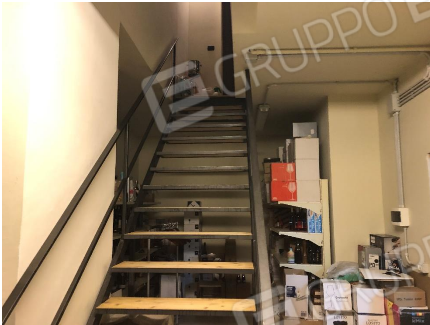
Foto n. 5: Ingresso sub. 28 realizzato tramite asola sul solaio dell'unità immobiliare soprastate (non oggetto di pignoramento) adibita ad attività commerciale
