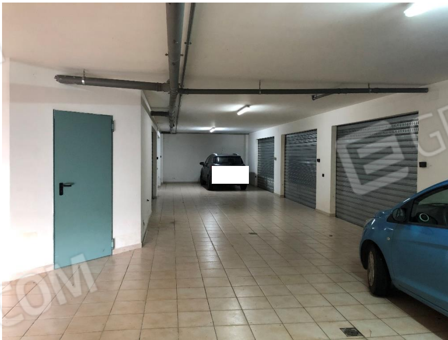
Foto n. 4: Area di manovra
