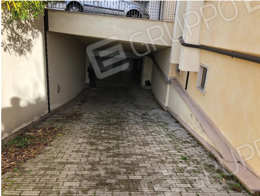
Foto n. 3: Rampa d'accesso all'area di manovra
