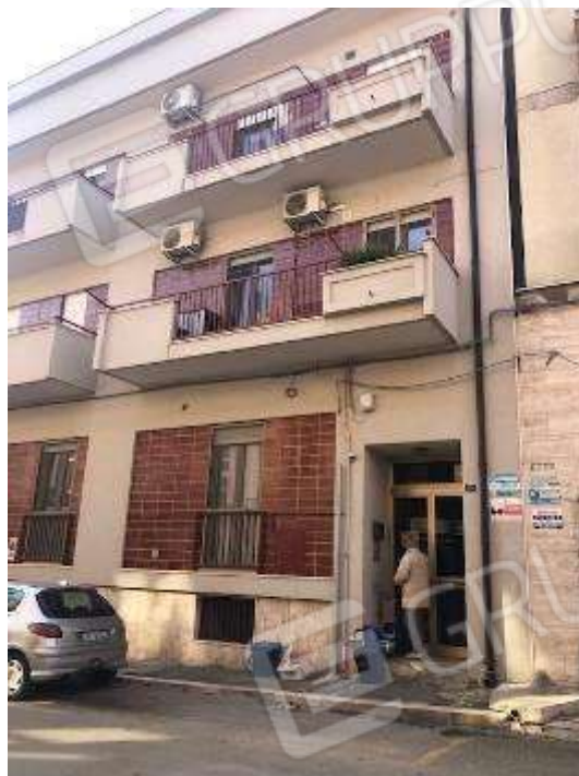
Accesso alla palazzina da Via Papa Giovanni XXIII
