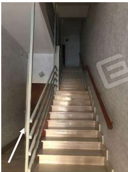
Androne e vano scale. La freccia indica l'ingresso dell'immobile.
