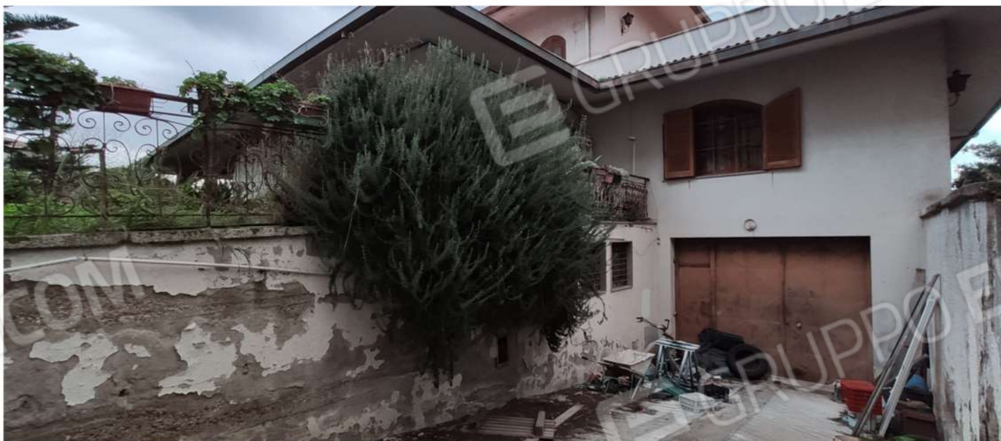
Foto 38 - Accesso al piano sottostrada
