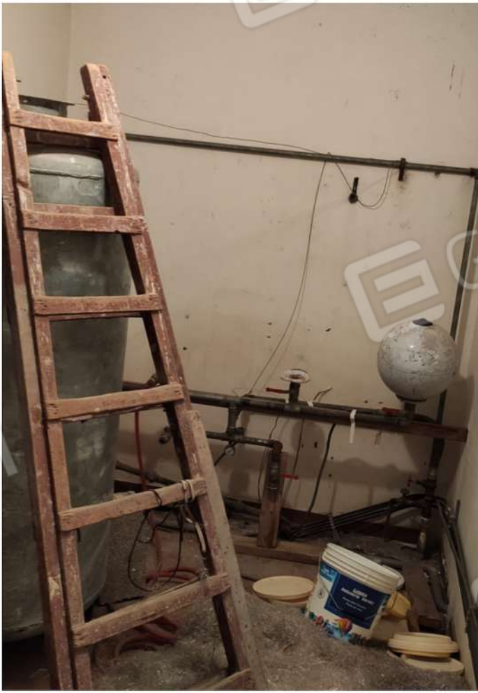
Foto 54 - Piano Sottostrada - Ripostiglio
