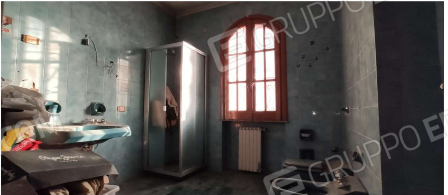
Foto 29 - Piano Primo - Bagno
