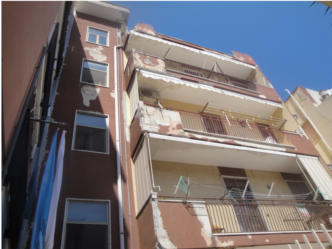
Foto 1: Abitato del Comune di Margherita di Savoia. Fabbricato sito alla Via Togliatti n. 5 (in cui si inserisce, al piano terzo, l'appartamento costituente il lotto 1). Vista del prospetto del fabbricato su Via Togliatti.
