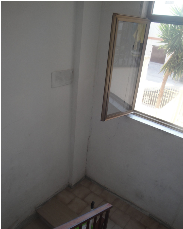
Foto 12: Abitato del Comune di Margherita di Savoia. Fabbricato sito alla Via Togliatti n. 5 (in cui si inserisce, al piano terzo, l'appartamento costituente il lotto 1). Interno del vano scala.
