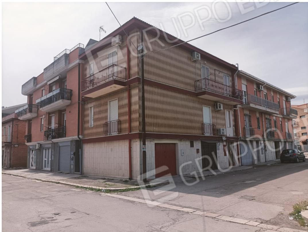
Vista immobile oggetto di causa (piano 1)
