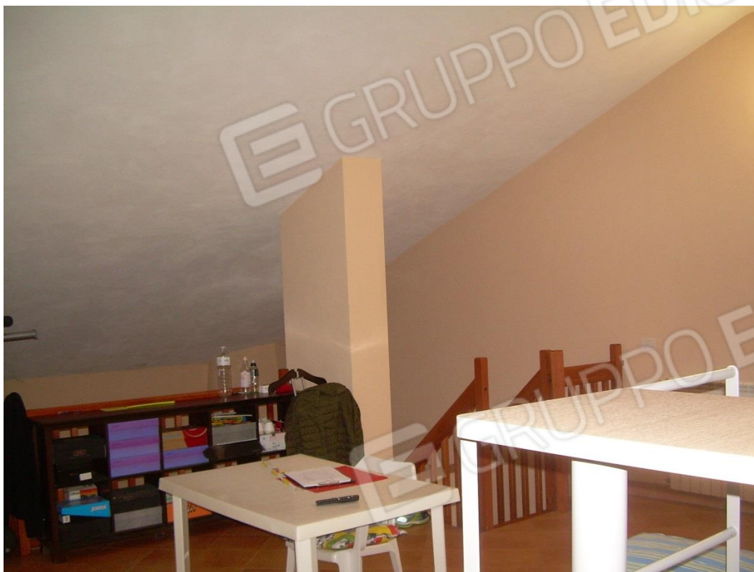
Foto n.16: vuoto sul soggiorno pranzo delimitato per due lati dalla balaustra in legno. Si nota la falda del tetto inclinata ed in angolo il prolungamento della muratura che riveste il sottostante camino del soggiorno.
