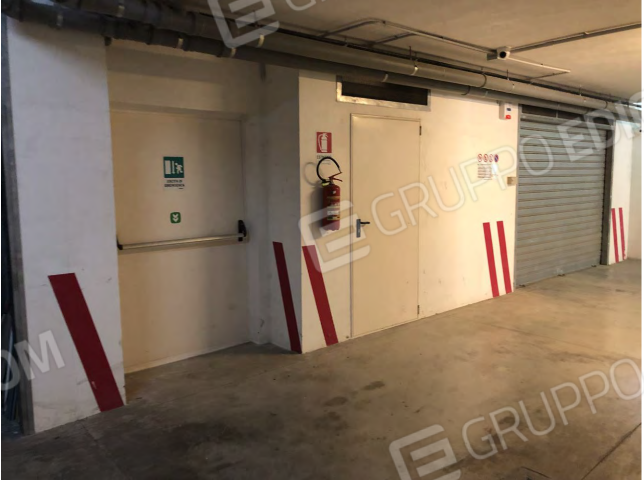
FOTO n. 05 – Vista corsia di manovra accesso box –
