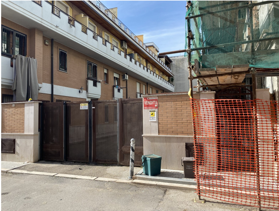
Foto 23: Ingresso rampa locale box di Via Deliceto 1BC.
