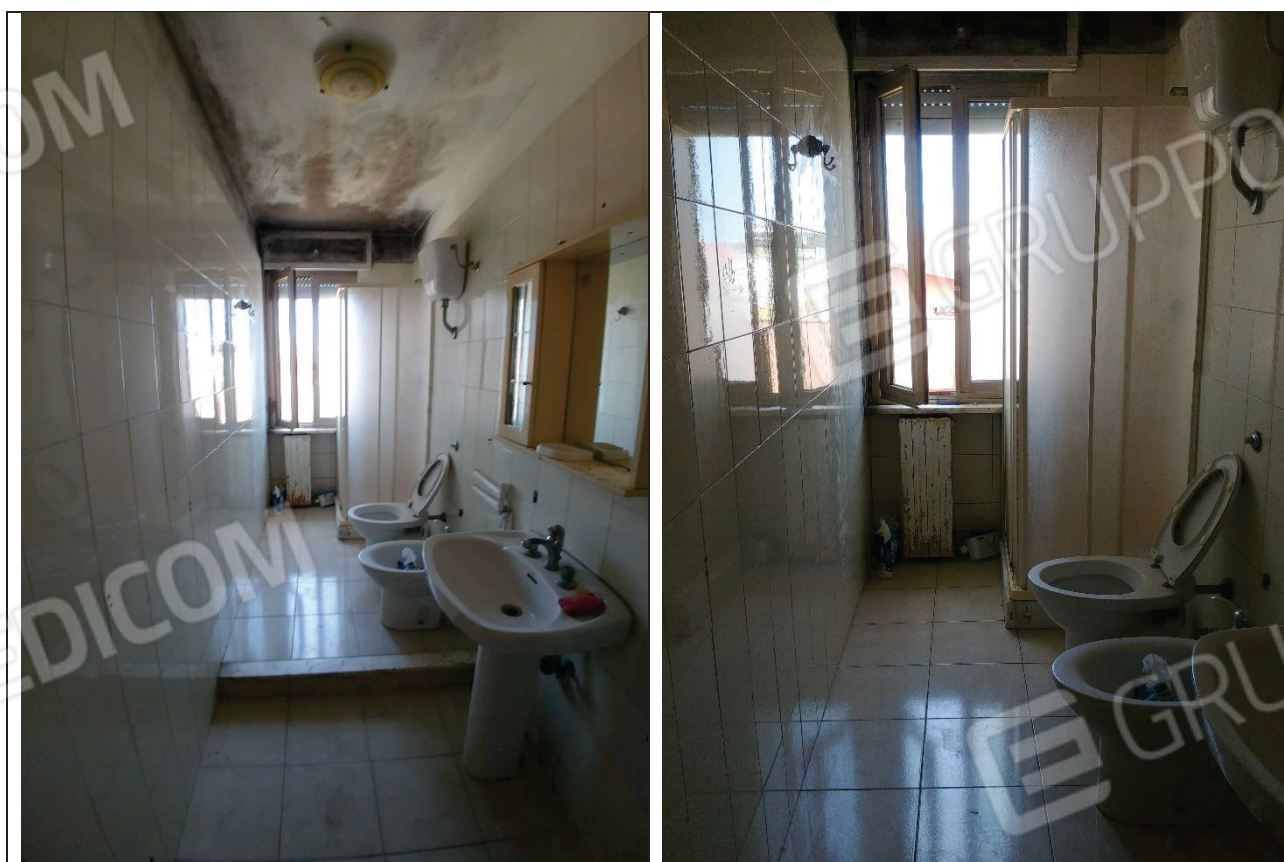
Figura 16: interno immobile con destinazione d'uso vani tecnici da C.E. 7304/87 (adibiti ad appartamento)
