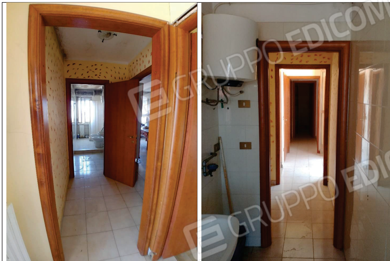
Figura 15: interno immobile con destinazione d'uso vani tecnici da C.E. 7304/87 (adibiti ad appartamento)
