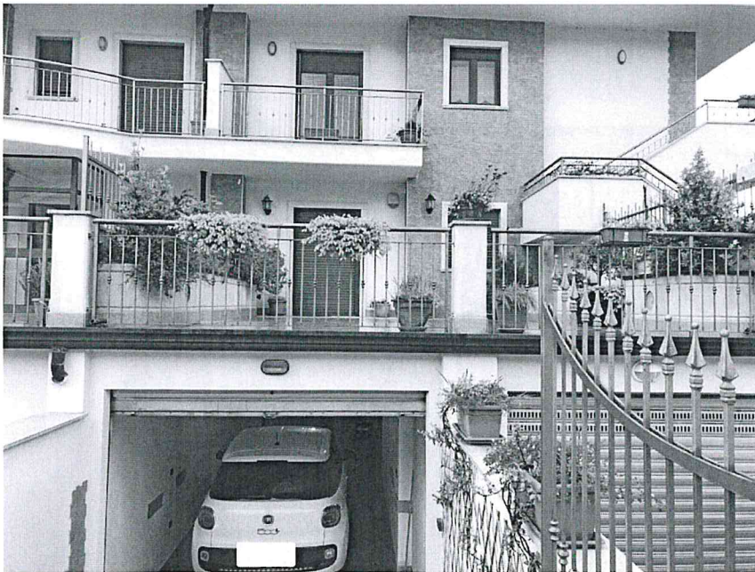
Foto n. 6: Ingresso box e vista terrazzo n. 2
