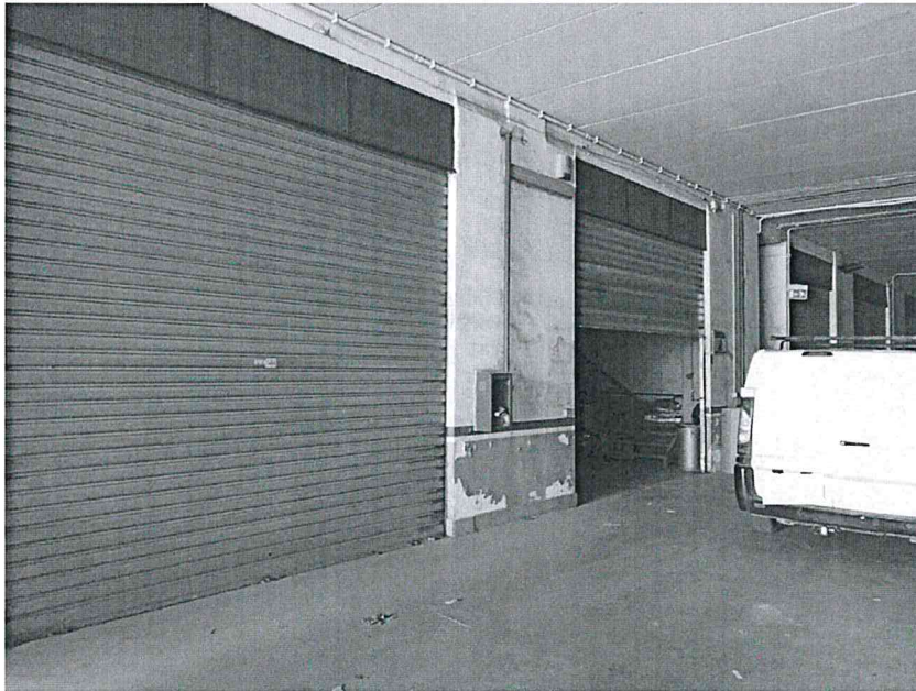
Foto n. 5: Ingresso box – sub. 23 – 24
