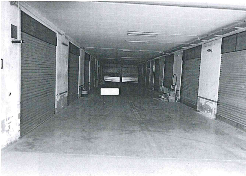
Foto n. 4: Area di manovra piano seminterrato
