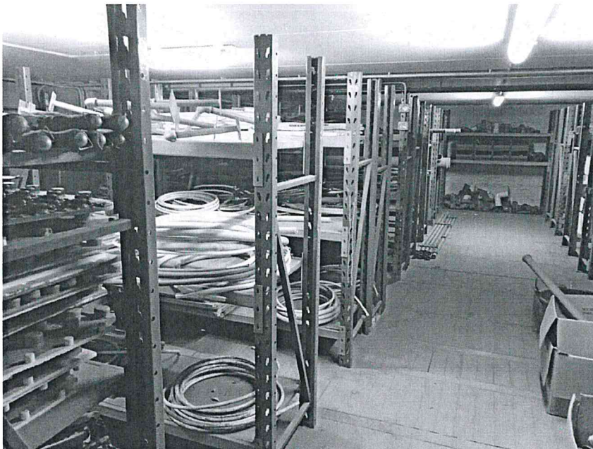
Foto n. 14: Soppalco in acciaio adibito a deposito
