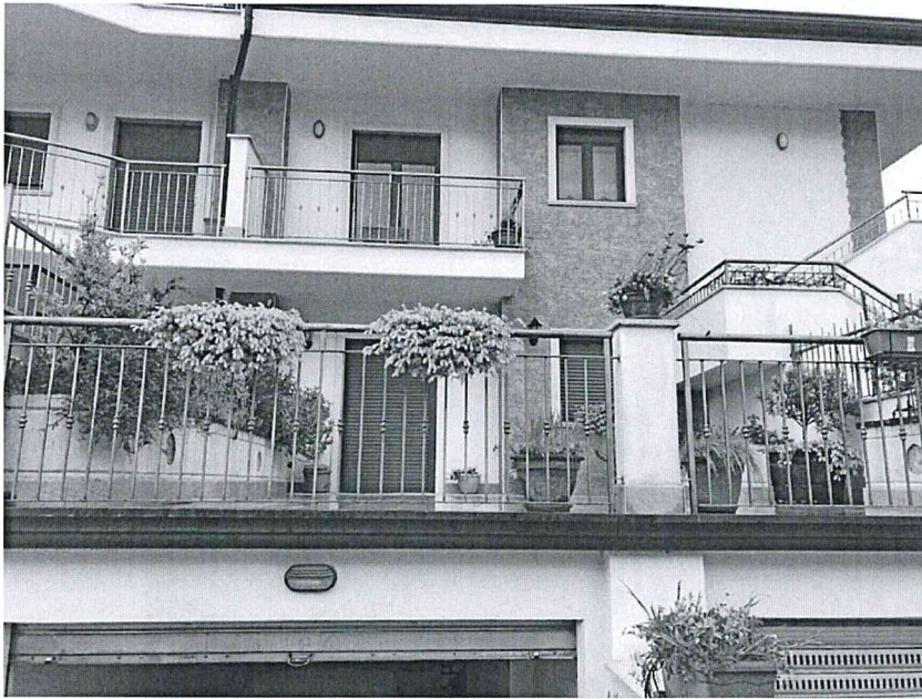
Foto n. 5: Vista terrazzo n. 2
