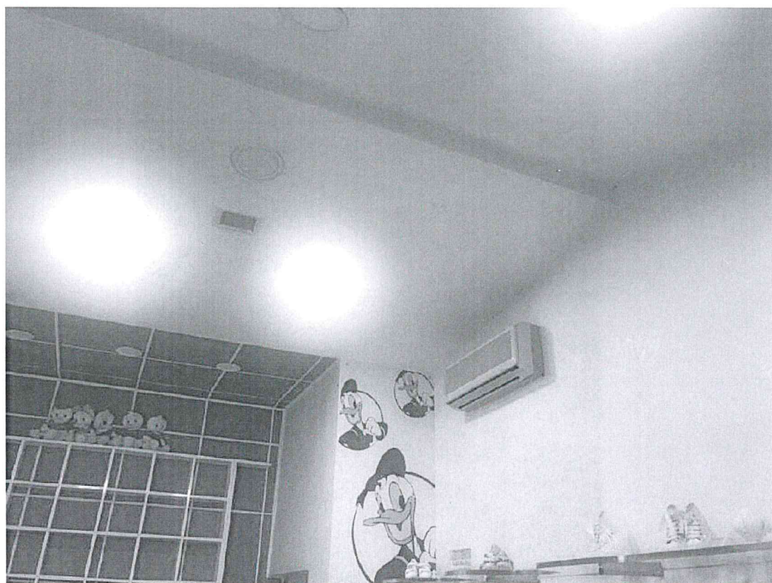
Foto n. 4 – Particolari interni del locale
