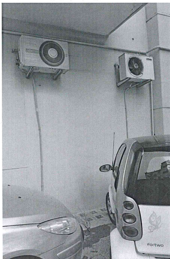
Foto n. 8 – Parte retrostante del locale con porta d'accesso (all'ex civico 134C) murata
