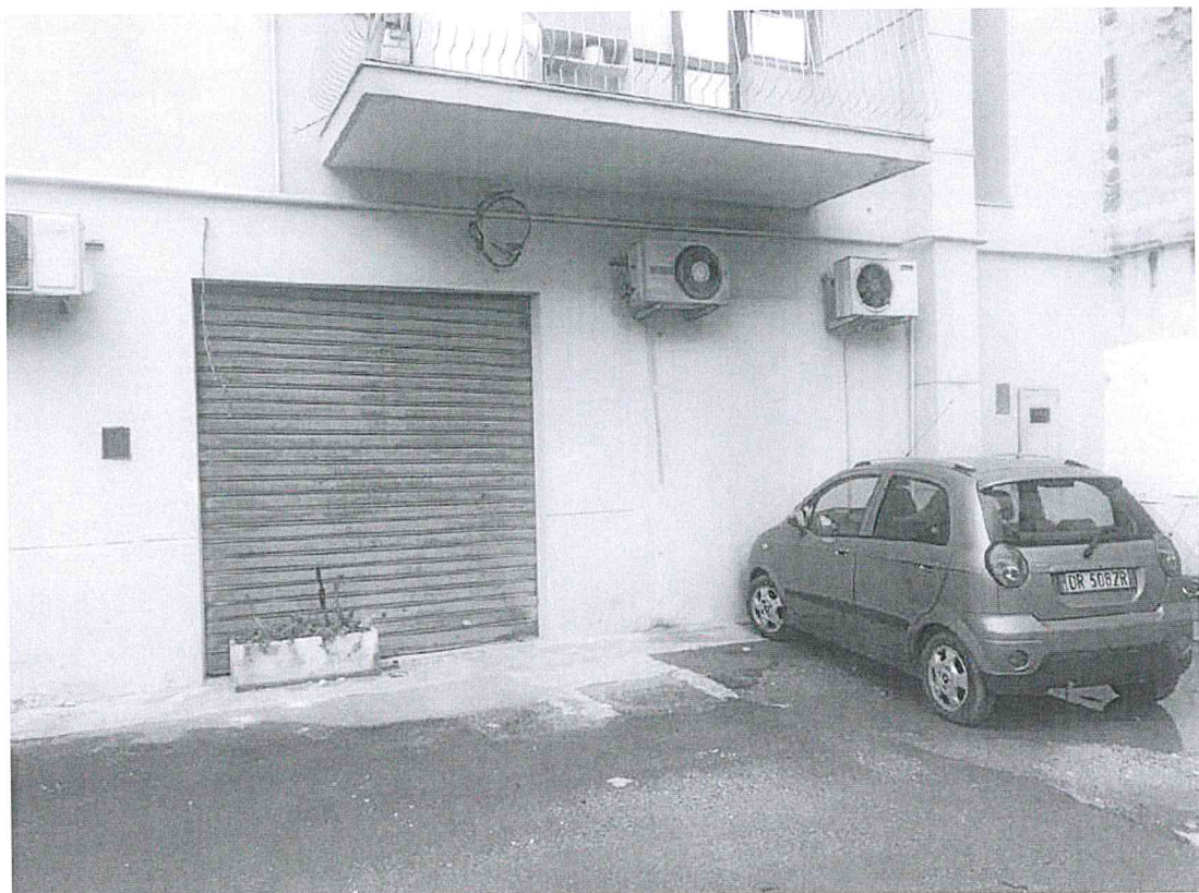
Foto n. 6 – Accesso (murato) al sub 12 dal Cortile interno Giannone
