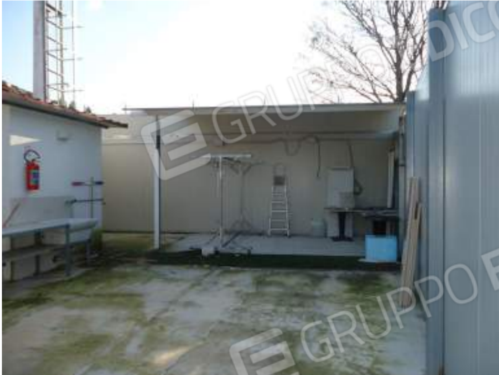
Foto n. 27 Tettoia esterna Sub. 7
