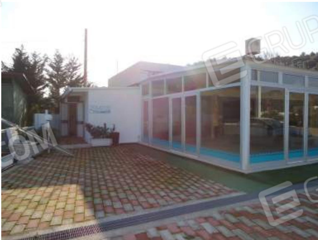
Foto n. 6 Vista Veranda e bagni lato Nord
