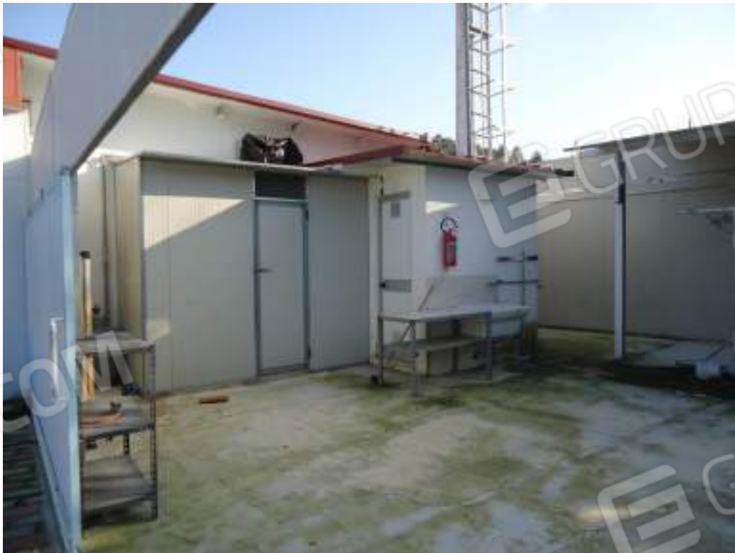
Foto n. 26 Bagno esterno e deposito
