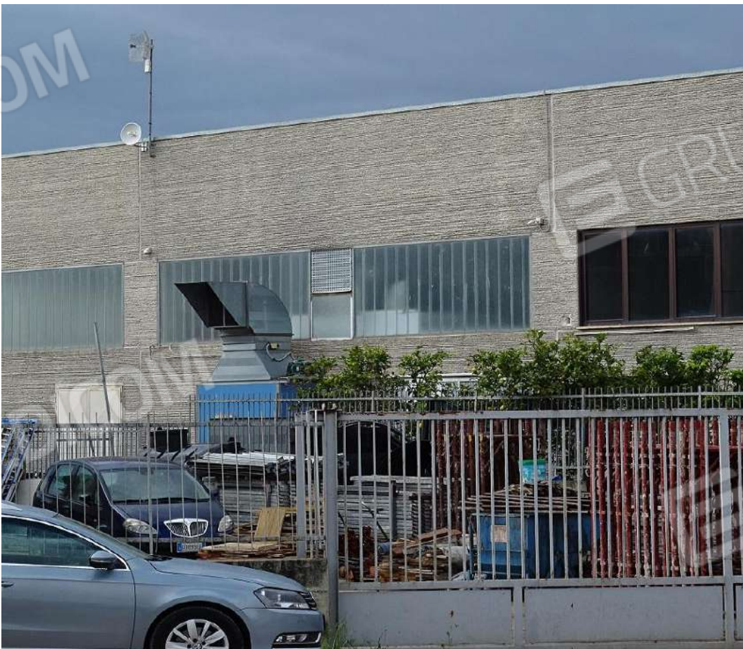
Foto n. 6 - 2° Sopralluogo Prospetto posteriore
