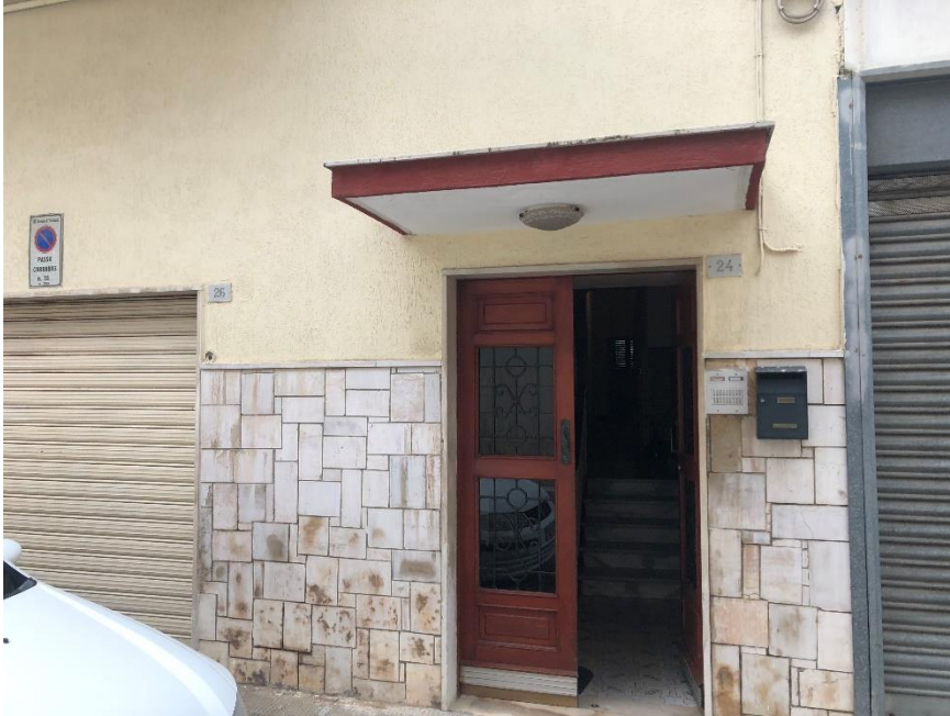
Foto n. 1: Ingresso appartamento piano rialzato – Via Labranca n. 24
