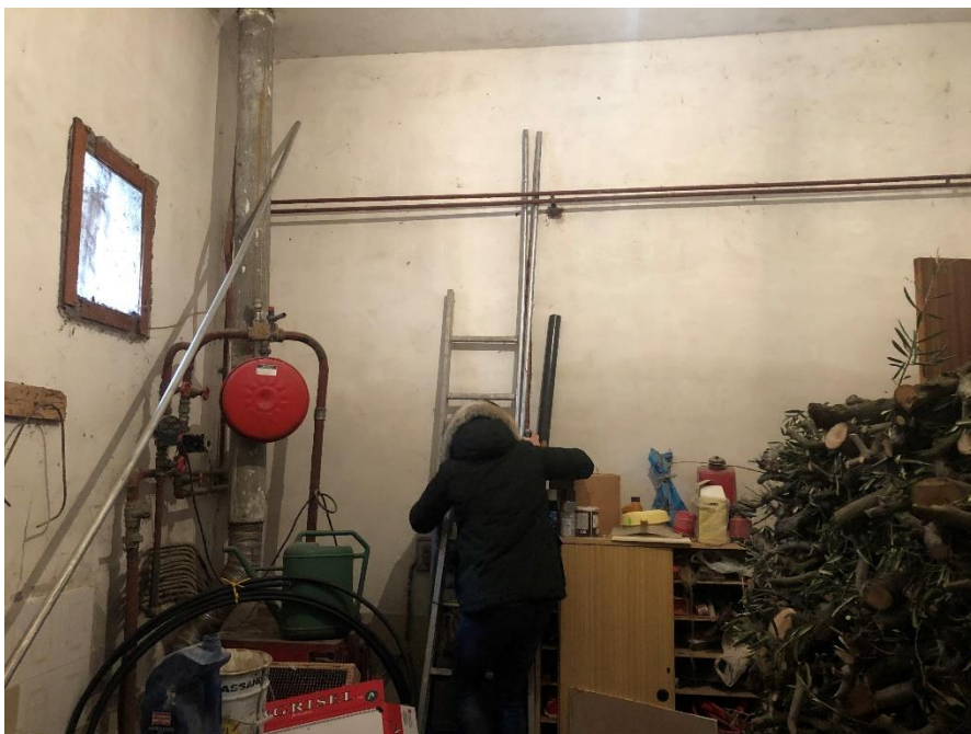
Foto n. 6: Locale autorimessa – part. 748 sub. 1
