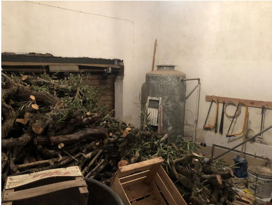
Foto n. 5: Locale autorimessa – part. 748 sub. 1
