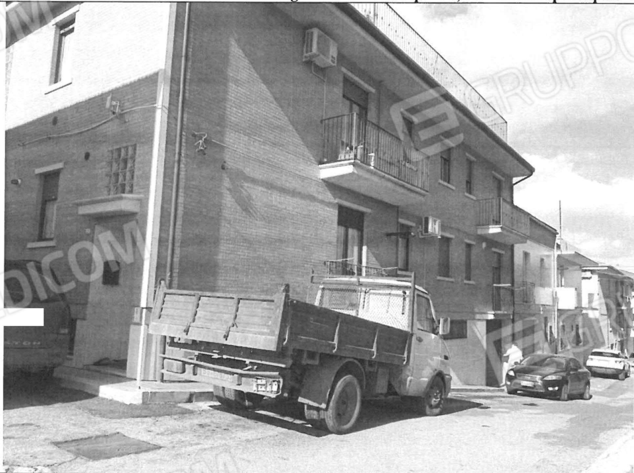
2 – Prospetto laterale su via Marziale
