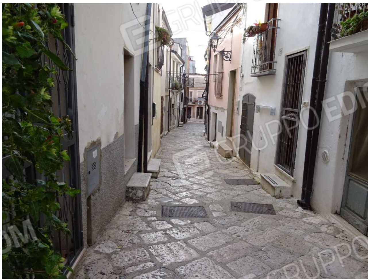
Foto terzo sopralluogo del 24.01.2024
