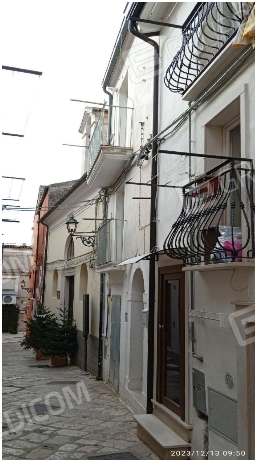
Foto secondo sopralluogo del 13.12.2023
