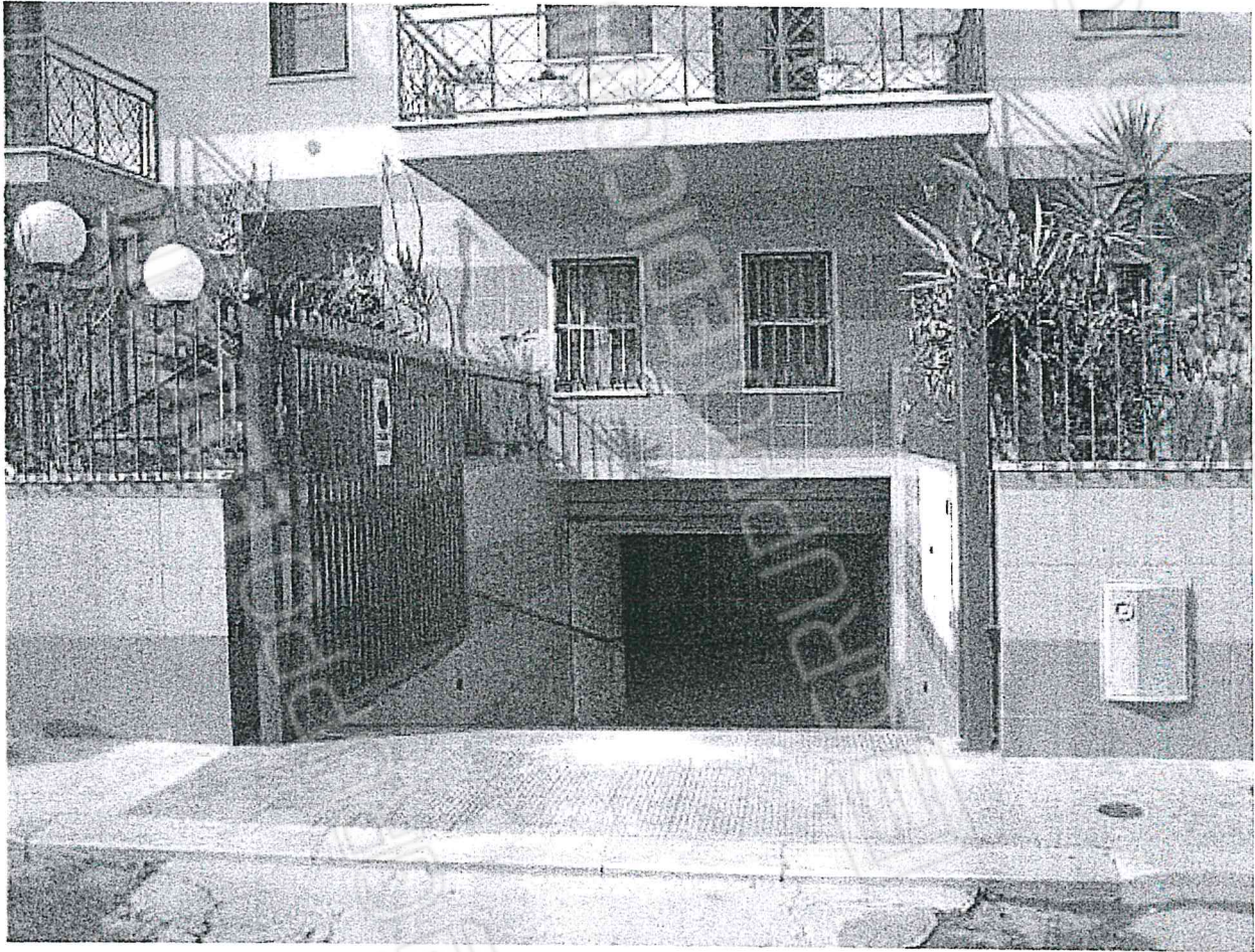
45 – Rampa di accesso ai box, dall'esterno.
