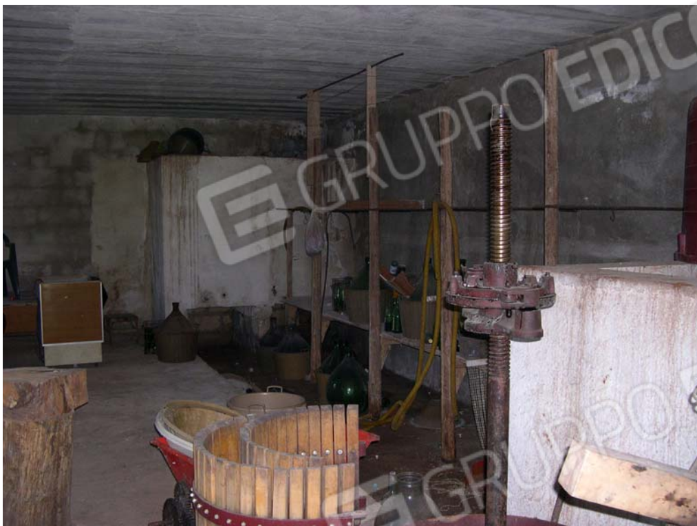
Foto n. 19 – veduta interna della cantina: vasca in muratura.
