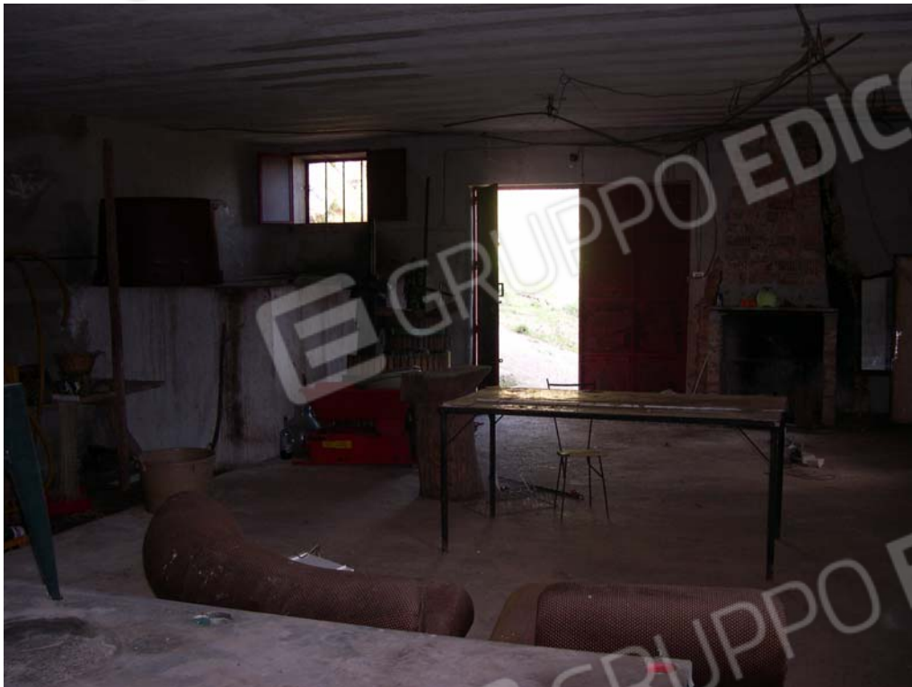
Foto n. 21 – veduta della finestra sul prospetto nord-ovest.
