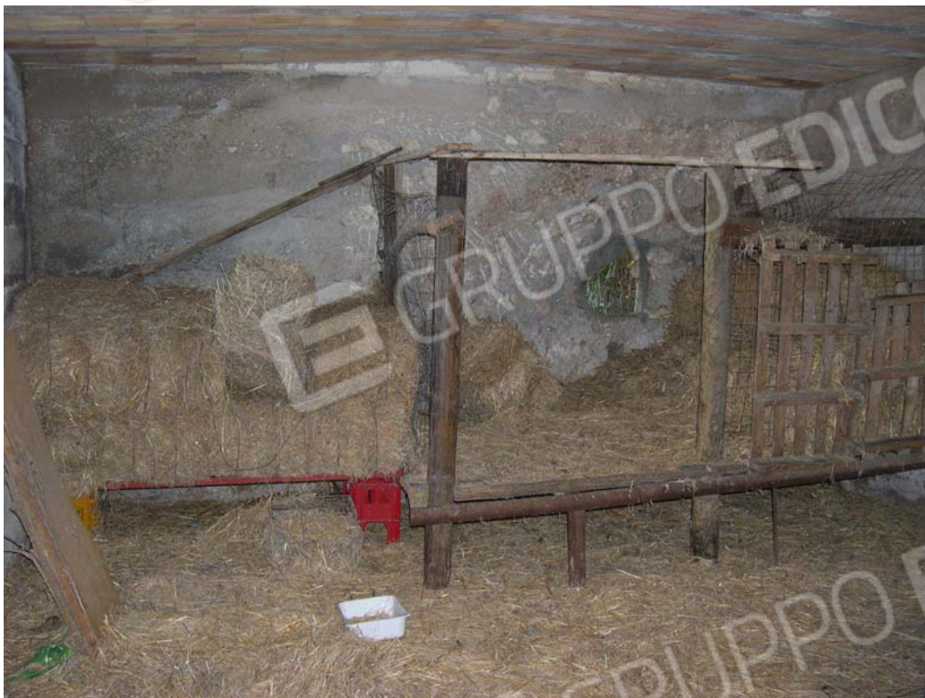
Foto n. 3 – Veduta interna dell'u.i. sita al piano -2 adibito a stalla.
