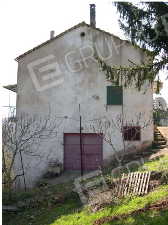
Foto n. 1 – Veduta esterna laterale del fabbricato sito in contrada Carpineto ad Ischitella.
