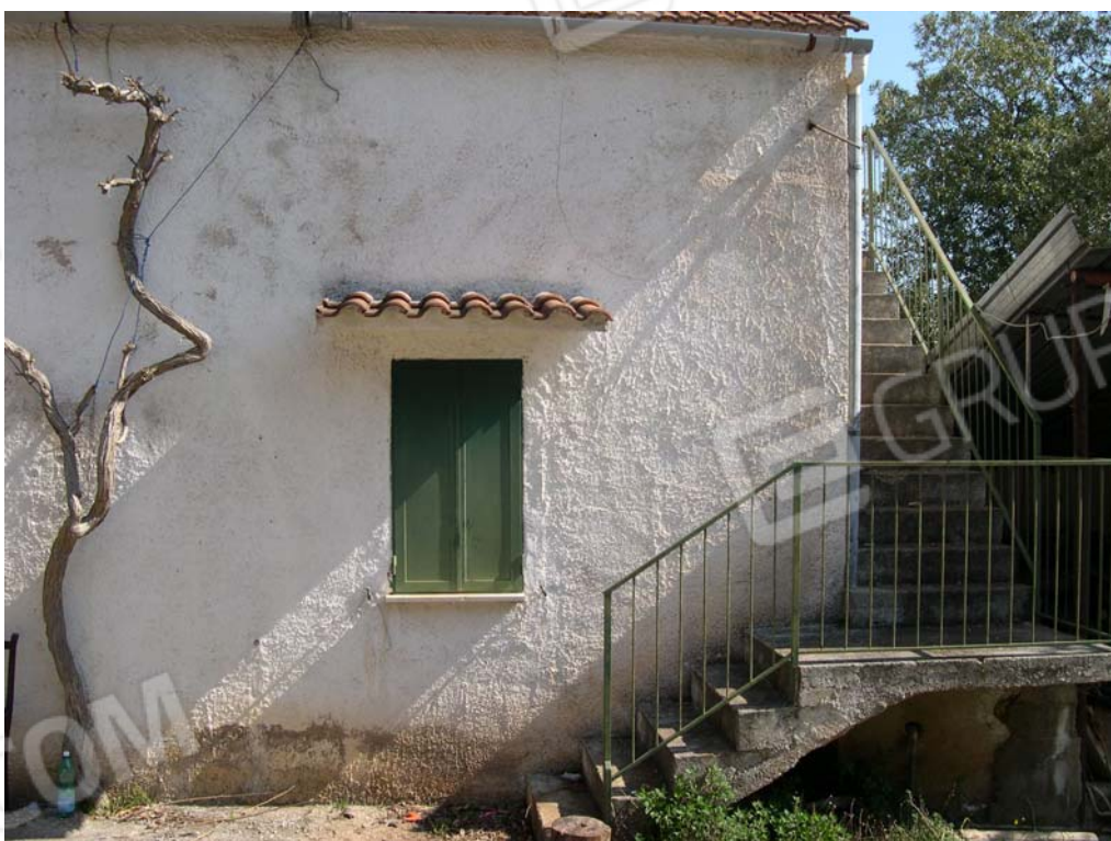
Figura n. 30 – veduta della scala esterna di accesso al sottotetto.
