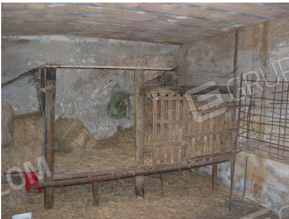
Foto n. 16 – veduta della finestra ricavata sul lato sud-est
