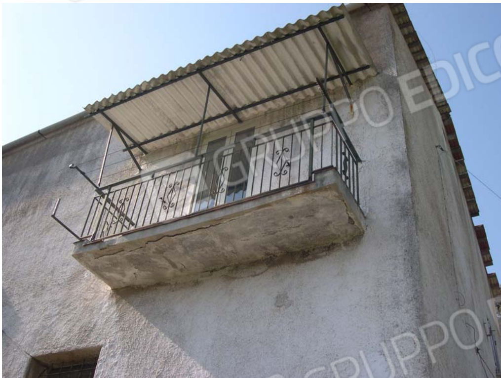
Foto n. 13 – Muratura nella parte superiore in tufo .
