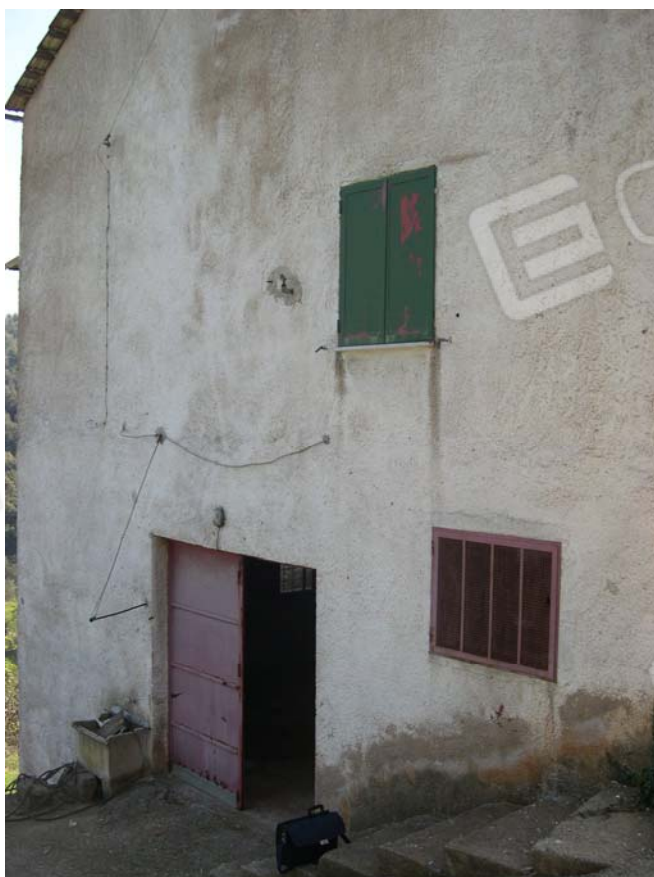
Foto n. 18 – veduta dell'accesso alla cantina sul lato nord-ovest.
