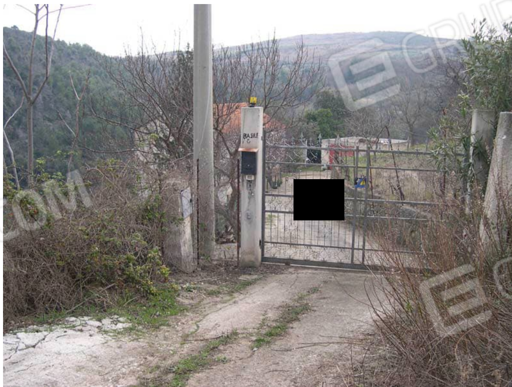
Foto n. 2 – Veduta esterna dell'ingresso all'immobile.
