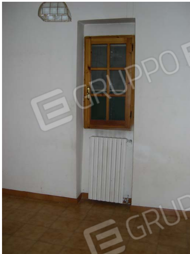
Figura n. 27 – veduta delle finestre presenti sul prospetto lato sud-est.
