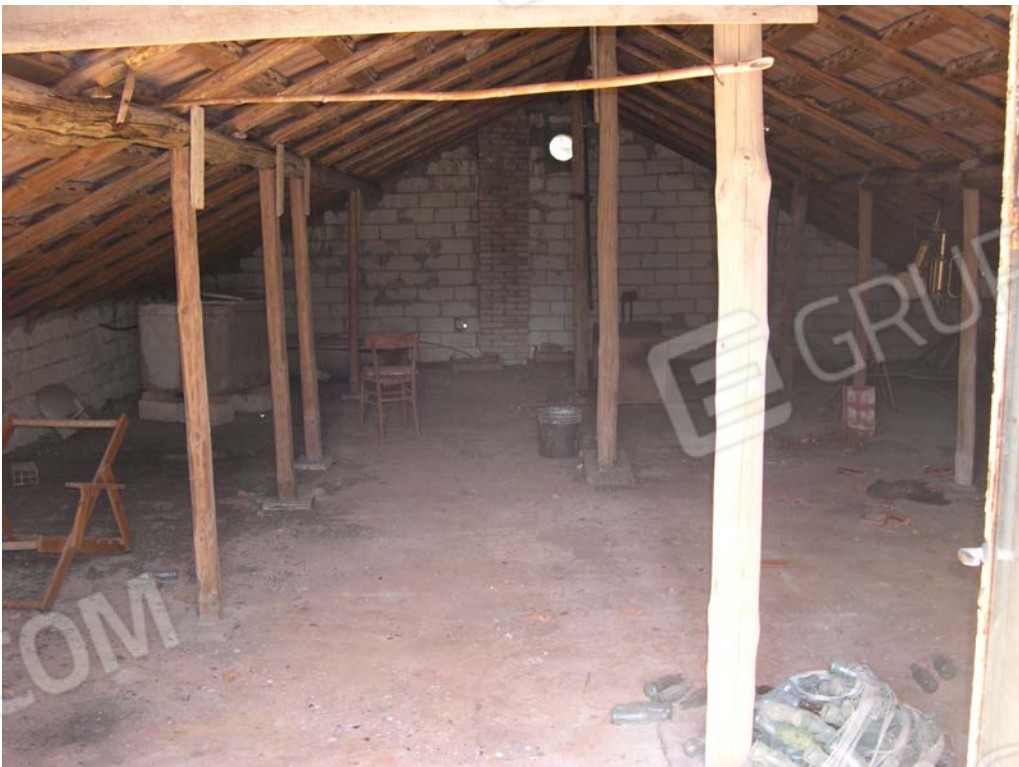
Foto n. 6 – Veduta interna dell’u.i. al piano primo adibito a deposito.
