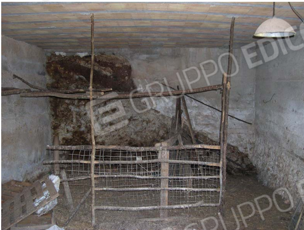
Foto n. 15 – veduta interna del piano -2 con le pareti realizzate su roccia.
