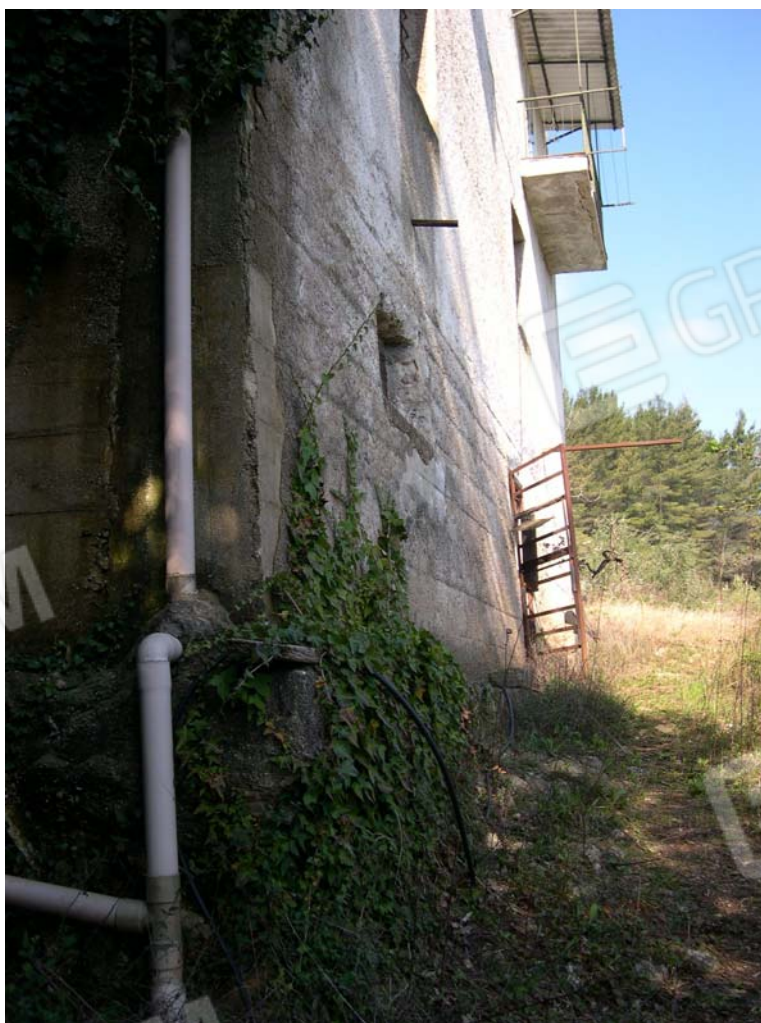
Foto n. 14 – veduta esterna dell'ingresso al piano inferiore del fabbricato.
