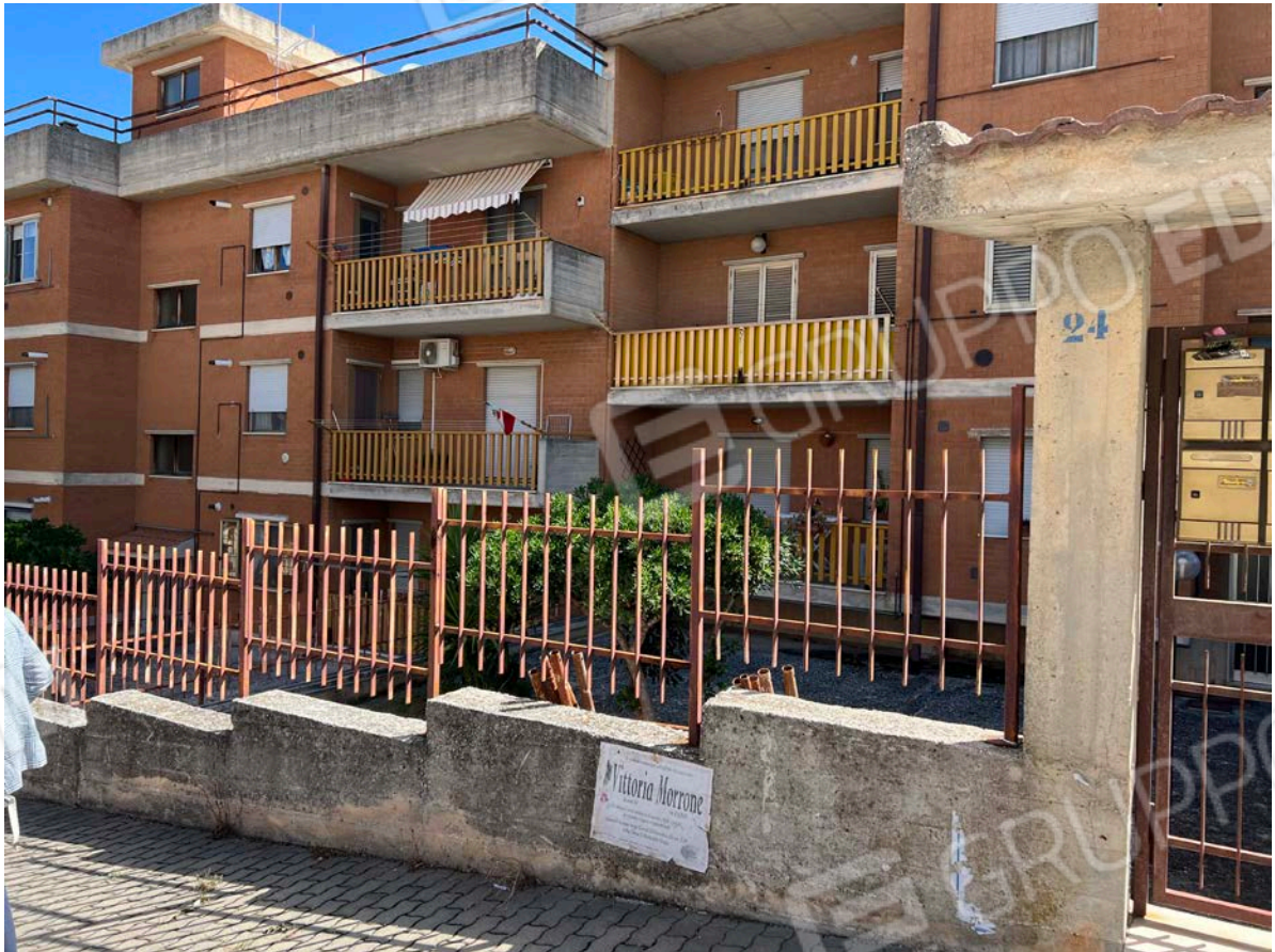
FOTO n. 1 – Prospetto principale edificio -
