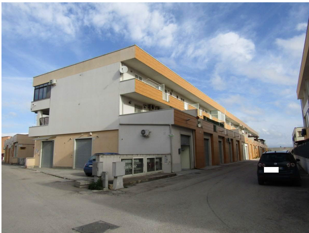
FOTO 25.1 - LOTTO 25 – BOX AUTO IN FOGGIA – FABBRICATO B
