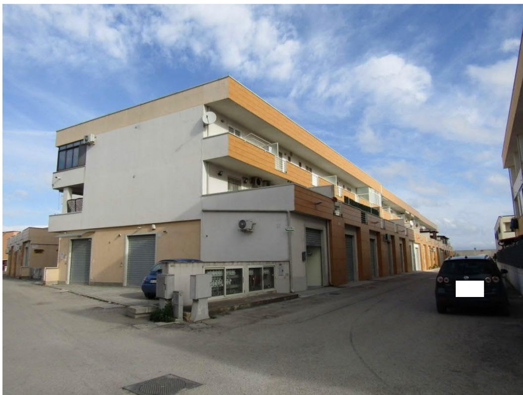
FOTO 26.1 - LOTTO 26 – BOX AUTO IN FOGGIA – FABBRICATO B
