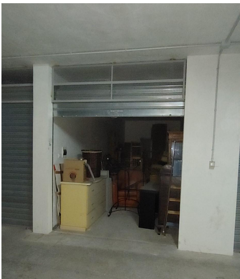
FOTO 26.6 - LOTTO 26 – BOX AUTO IN FOGGIA – PRIMO PIANO INTERRATO – INGRESSO
