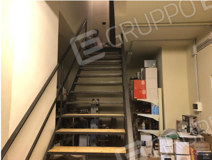
Foto n. 5: Ingresso sub. 28 realizzato tramite asola sul solaio dell'unità immobiliare soprastante (non oggetto di pignoramento) adibita ad attività commerciale
