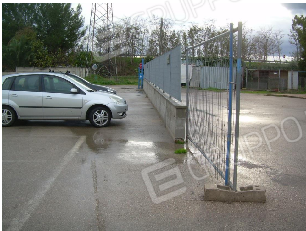
Foto n.6: recinzione in acciaio zincato su muro in blocchi di calcestruzzo pressovibrati.
