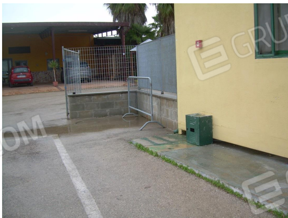
Foto n.6: recinzione in acciaio zincato su muro in blocchi di calcestruzzo pressovibrati.
