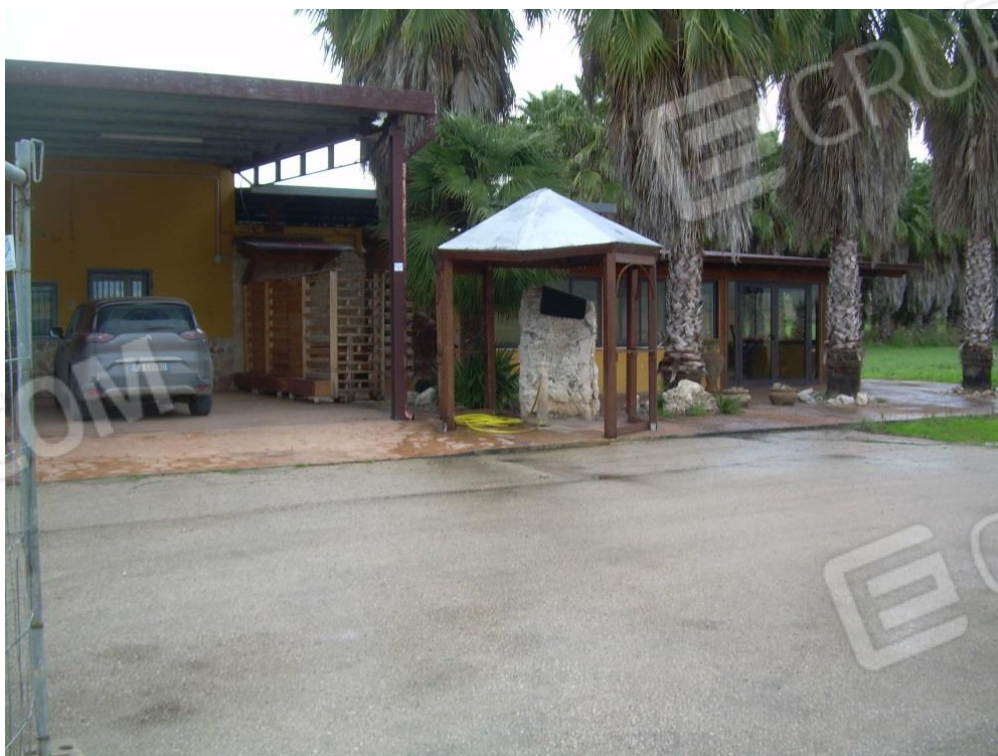
Foto n.22: lato est della "casetta d'appoggio", ed in prosecuzione la porzione di tettoia in legno chiusa lungo il perimetro con muratura e infissi vetrati, dietro il gazebo e gli alberi di palma.
