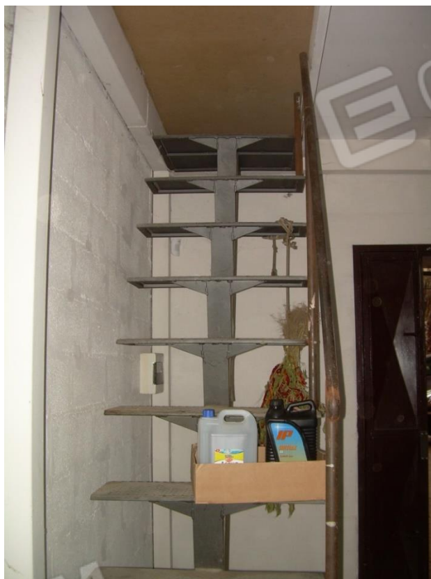
Foto n.14: scala in metallo interna all'Ufficio da cui si accede al soppalco di limitata altezza interna, sottofalda. A destra si nota, oltre alla controsoffittatura, la parete in blocchetti di cemento presso vibrati del capannone originario, e parte della struttura portante della tettoia addossata al muro.
