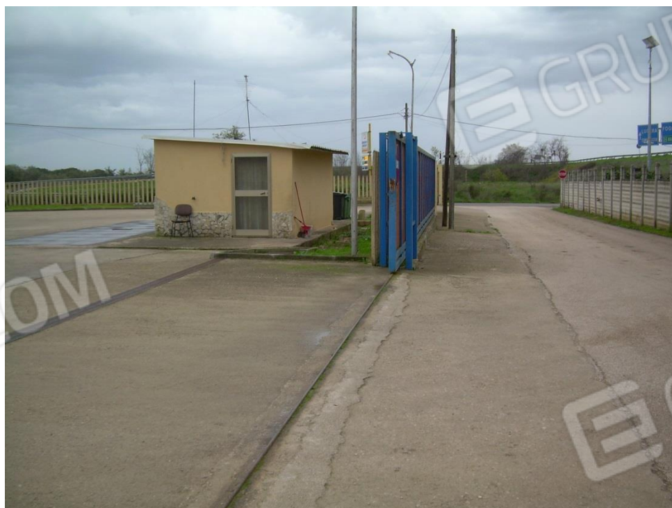
Foto n.2: ingressi per entrare ed uscire dal complesso immobiliare al fl. 97 p.lla 68, ubicati sul tratturo Foggia Aquila, ortogonale alla SP 109 San Severo-Lucera. In primo piano, i cancelli scorrevoli, il locale pesa, in basso la superficie del bilico (al piano interrato), oltre la strada di accesso Foggia-Aquila.
