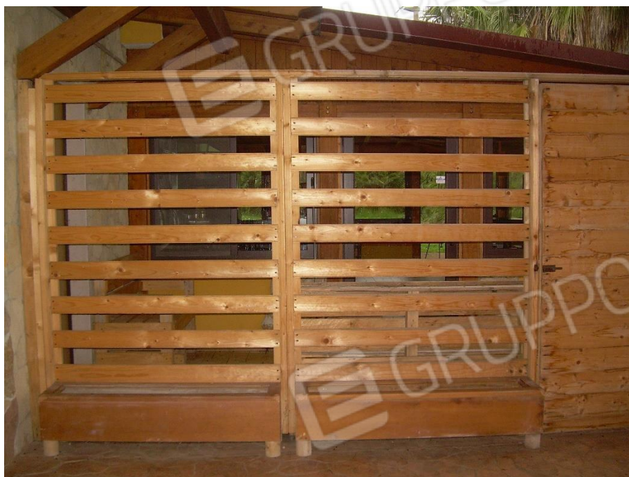
Foto n.23: struttura laterale della tettoia in legno coperta, che si diparte dopo la pensilina sovrastante l'apertura sopra il vano porta della "casetta d'appoggio".
