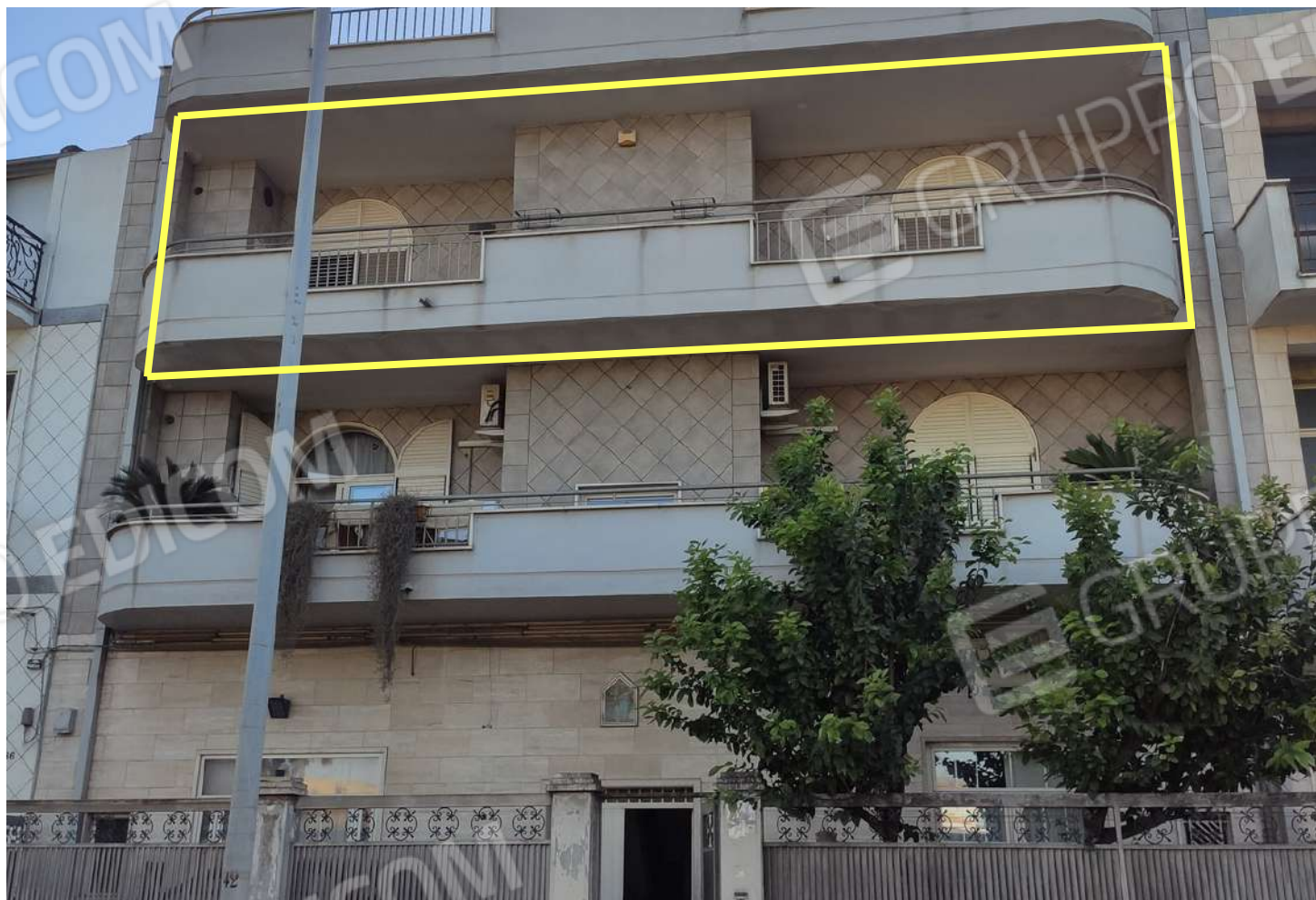
Foto 3 - Abitazione di tipo economico - Fgl. 162 P.Ila 944 Sub. 7
