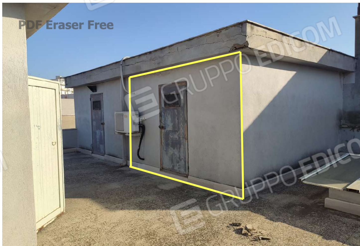
Foto 4 - Deposito Fgl. 162 P.lla 944 Sub. 11
